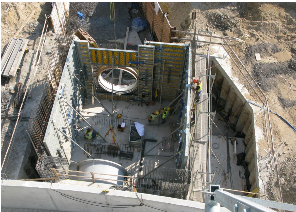
Obrázek 22 - Stavba armaturní komory pro umístění uzavírací klapky na nátokovém kanálu
