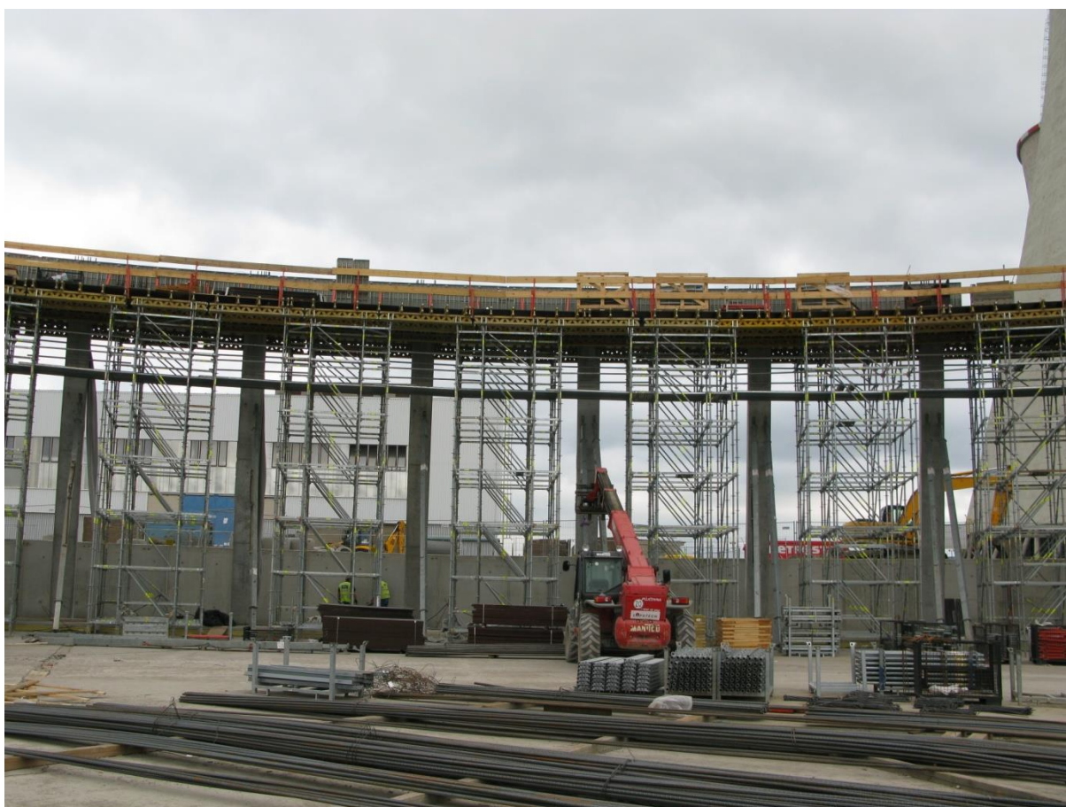
Obrázek 8 - Bednění prvního pásku
