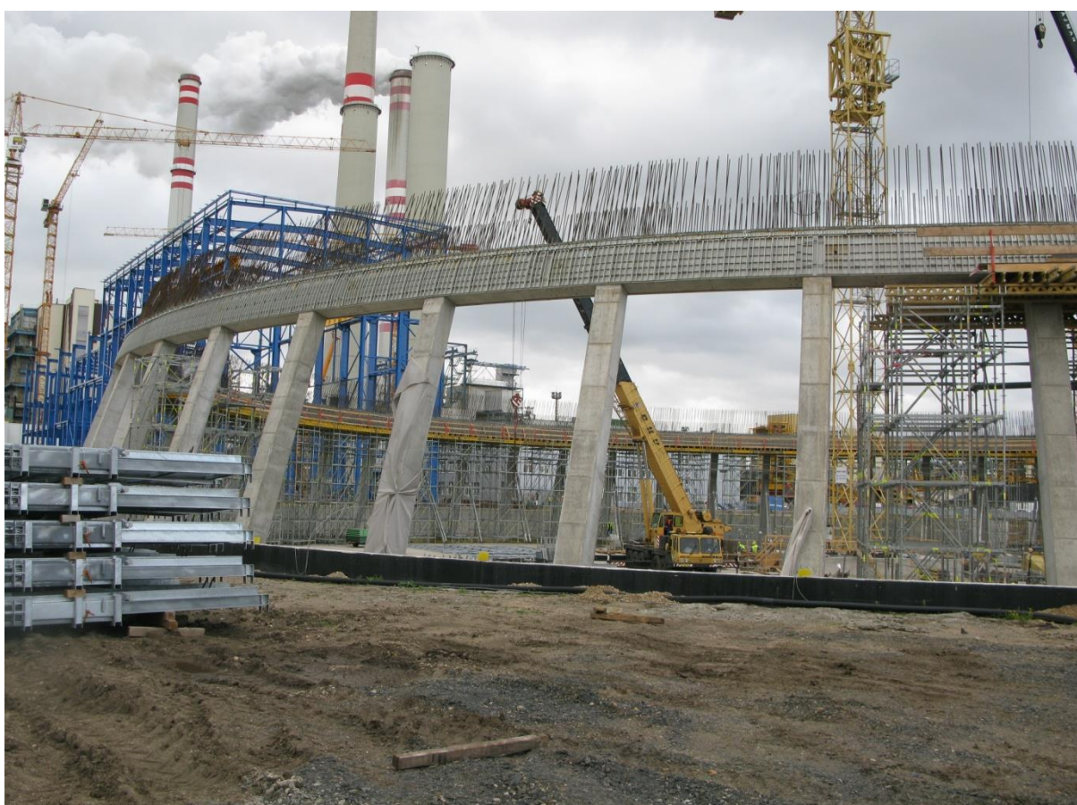
Obrázek 12 - První pásek po demontáži podepření
