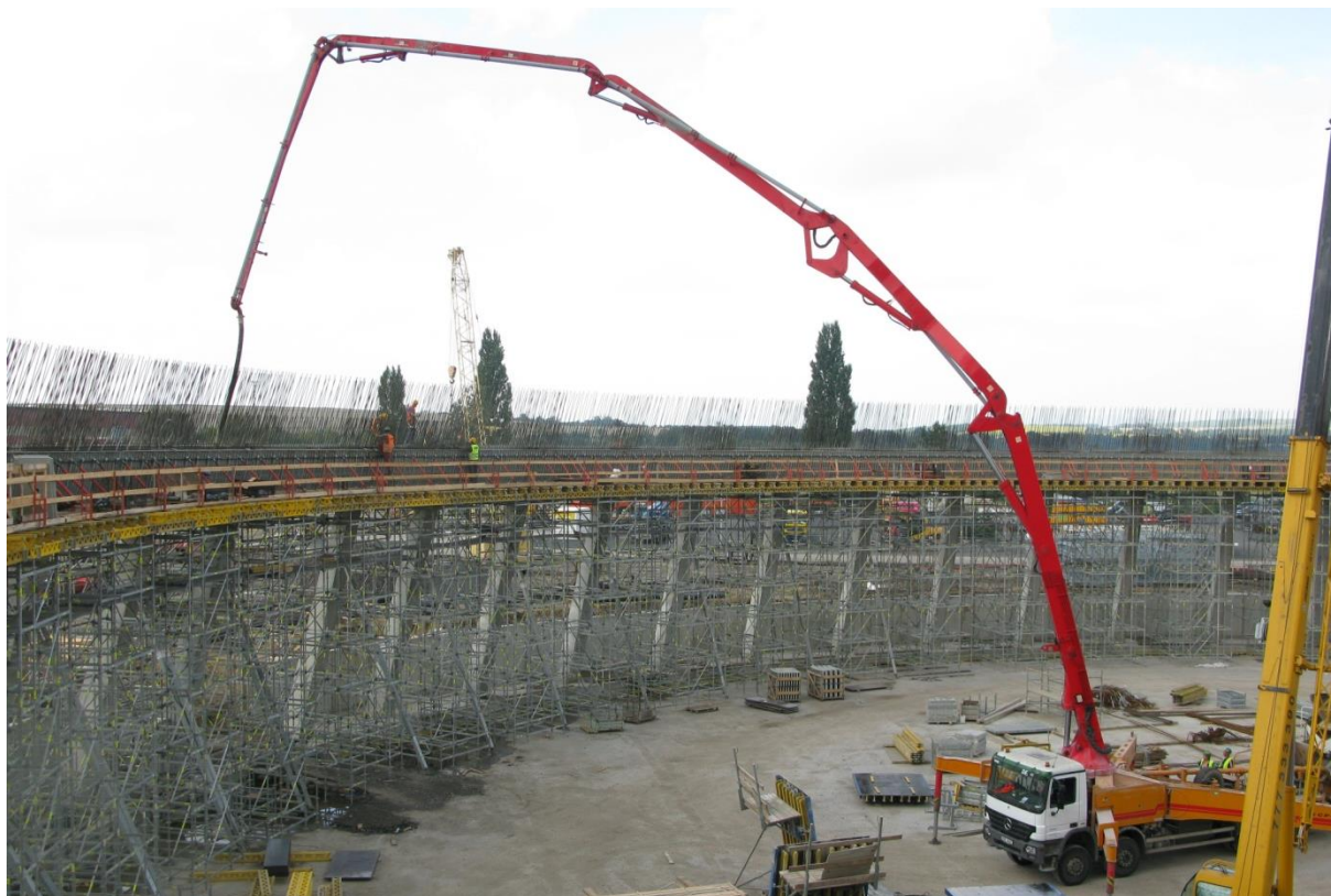
Obrázek 9 - Betonáž prvního pásku (návodního křídla)
