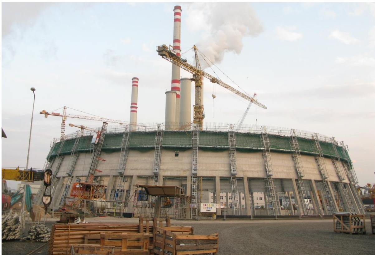
Obrázek 23 - Soubor zařízení před betonáží 7. pásku
