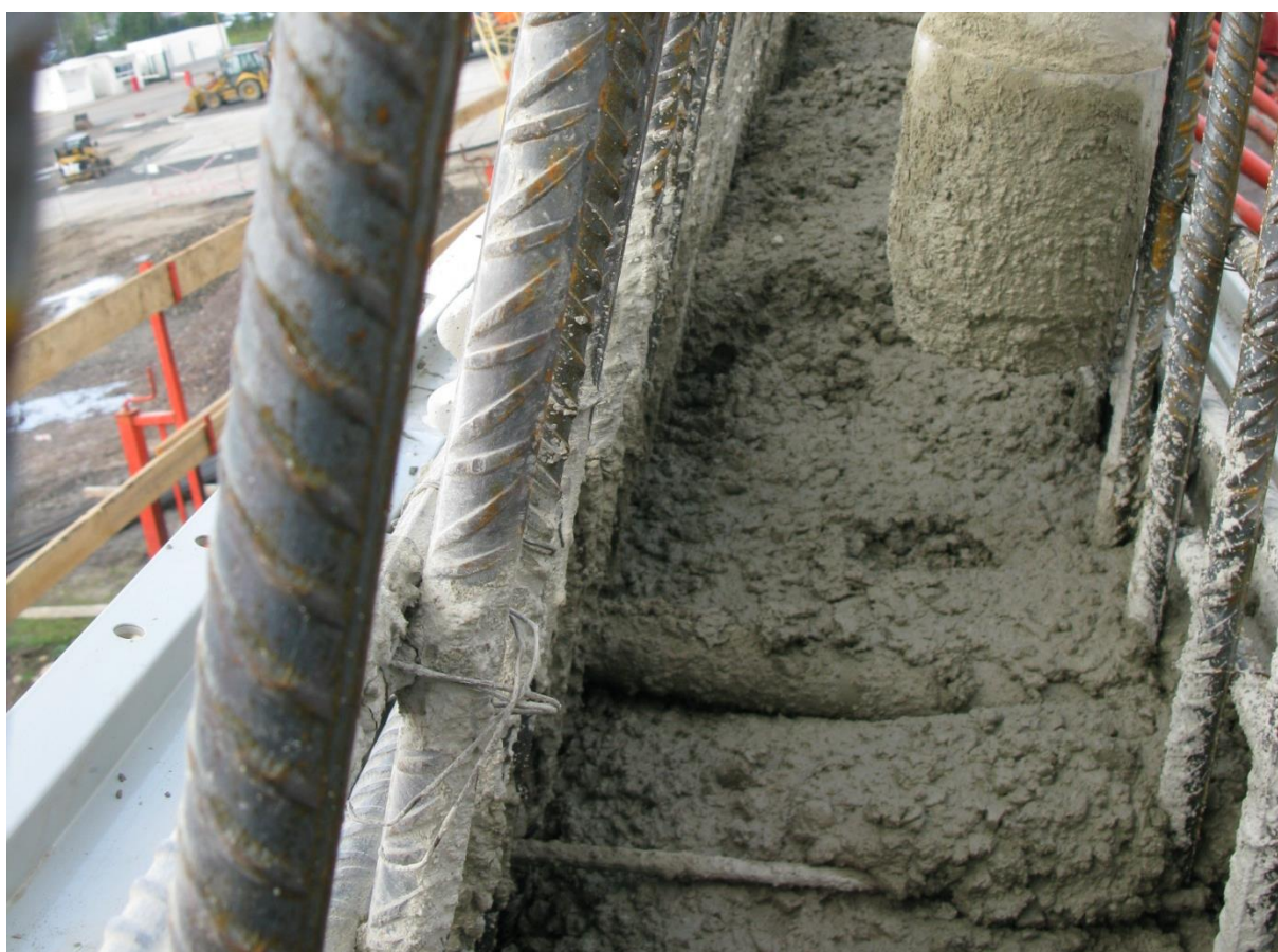
Obrázek 10 - Betonáž prvního pásku - detail
