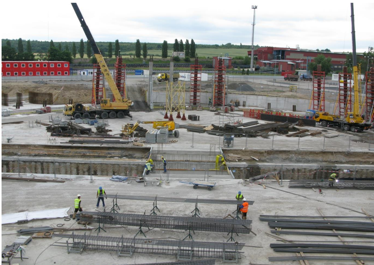
Obrázek 5 - Provádění betonáže širokých stojek
