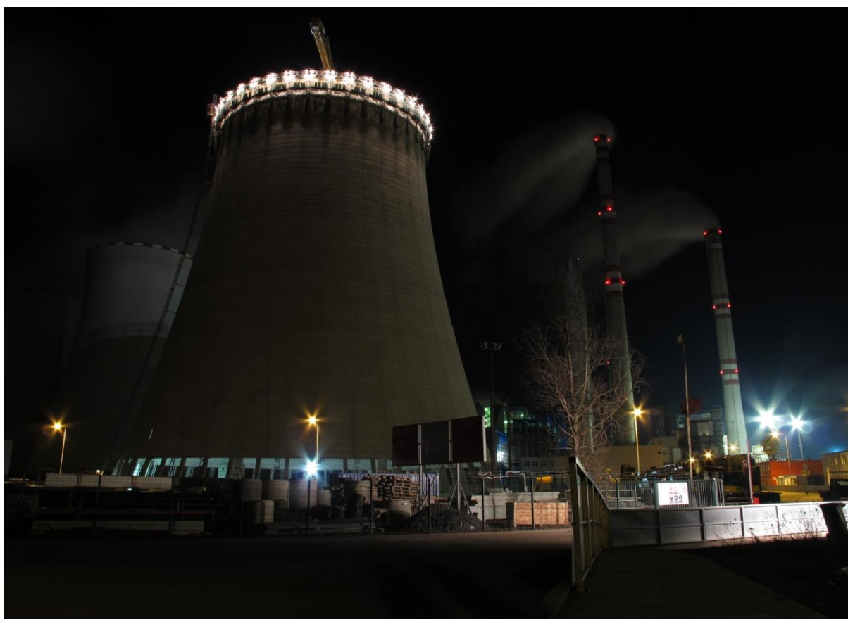
Obrázek 38 - Pohled na soubor zařízení a provoz staveniště v noci
