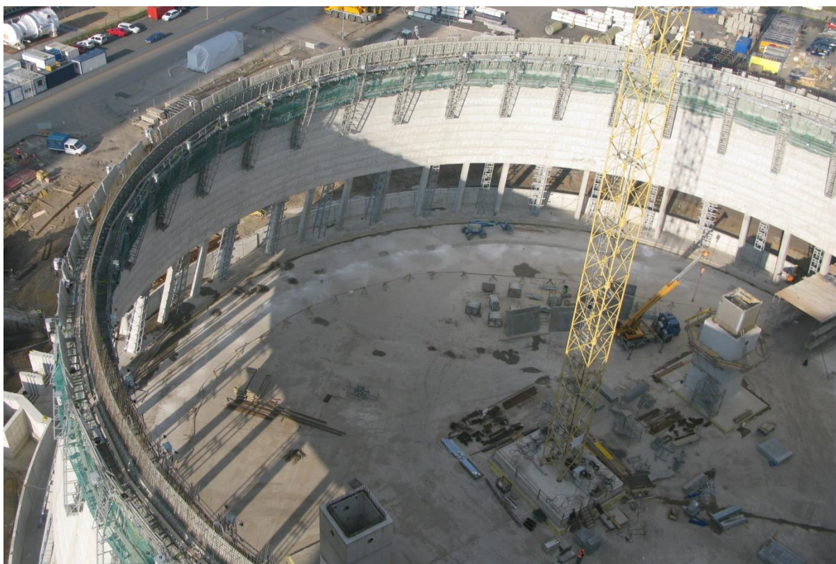
Obrázek 26 - Soubor zařízení při betonáži 15. pásku - probíhá zabetonování
