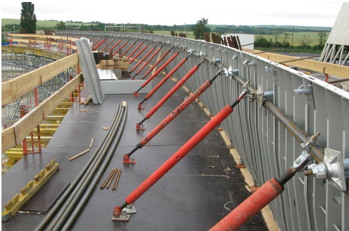
Obrázek 7 - Bednění prvního pásku (návodního křídla)
