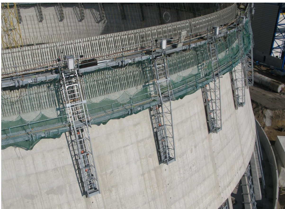
Obrázek 32 - Soubor zařízení spolu s bednicím systémem a instalovanými záchytnými sítěmi
