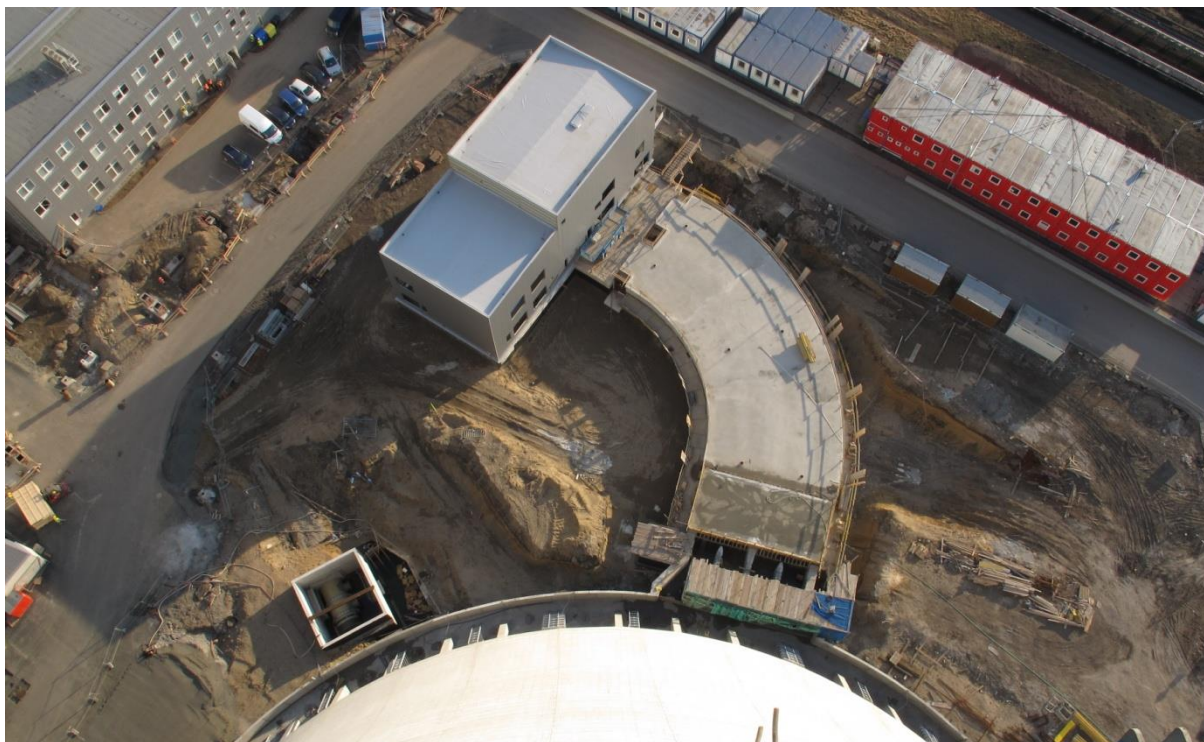
Obrázek 35 - Pohled na dokončování čerpací stanice a odtokového kanálu věže
