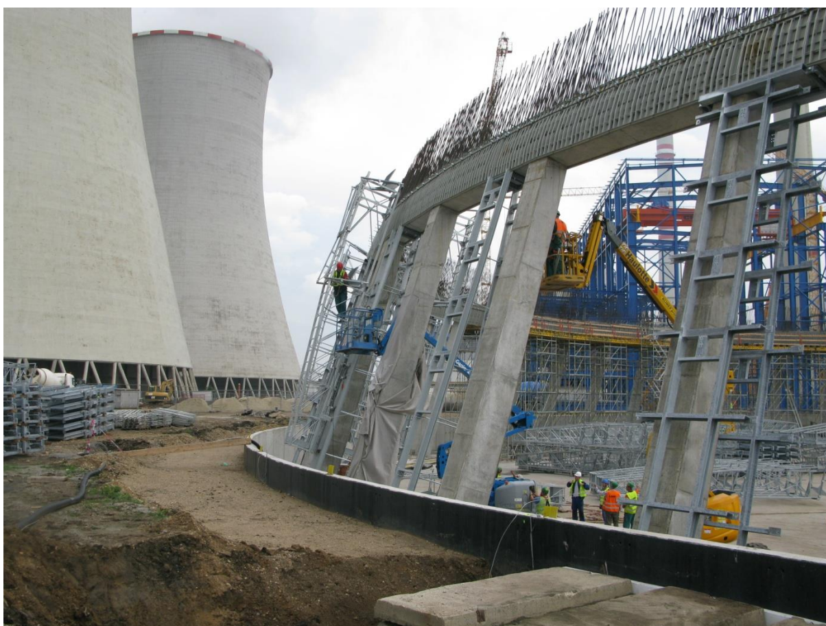
Obrázek 14 - Navěšování souboru zařízení
