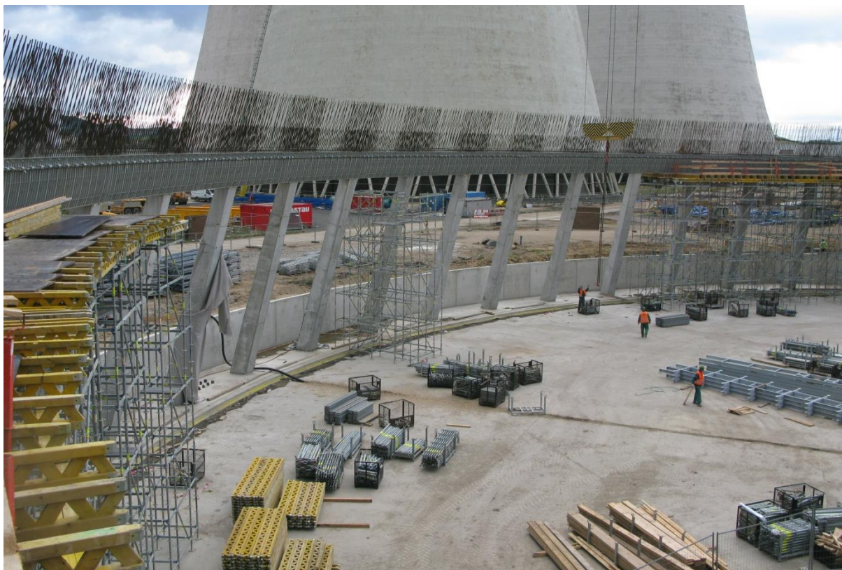
Obrázek 11 - Demontáž podepření prvního pásku
