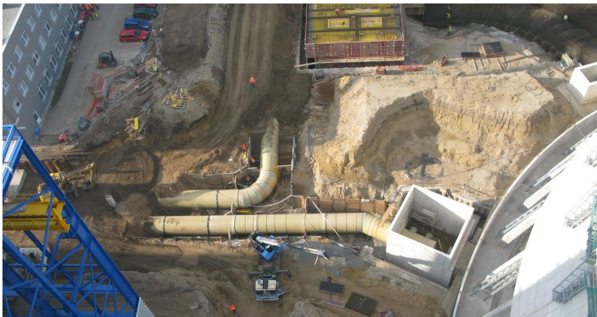
Obrázek 27 - Provádění zásypů nátokového potrubí
