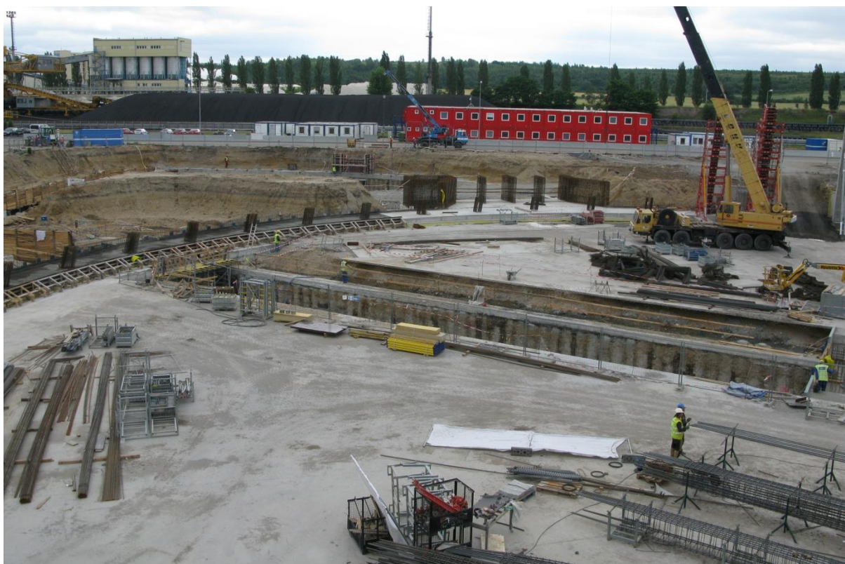
Obrázek 4 - Založení šikmých stojek
