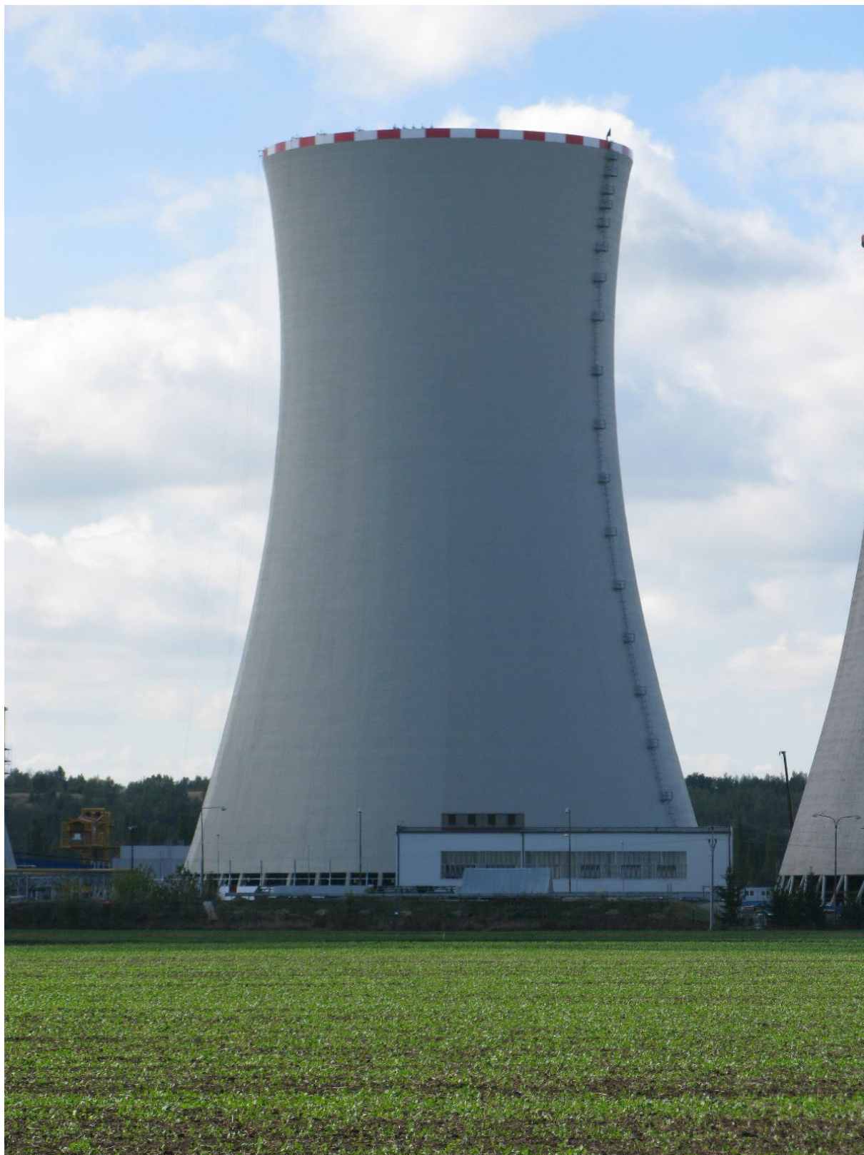
Obrázek 40 - Dokončená chladicí věž
