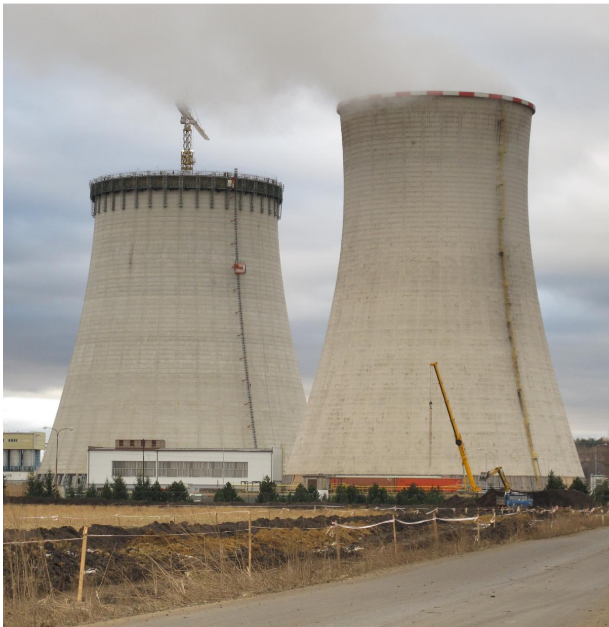
Obrázek 39 - Soubor zařízení v průběhu výstavby
