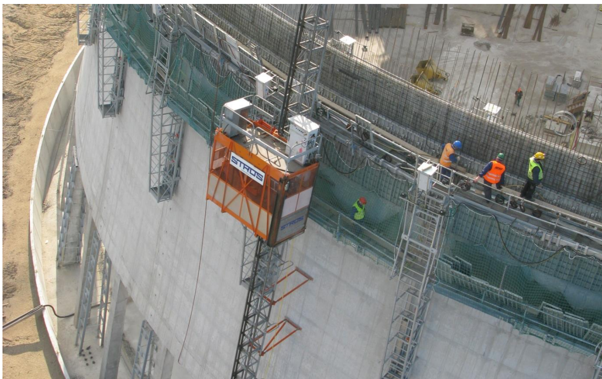
Obrázek 30 - Osobní kabina v úrovni souboru zařízení
