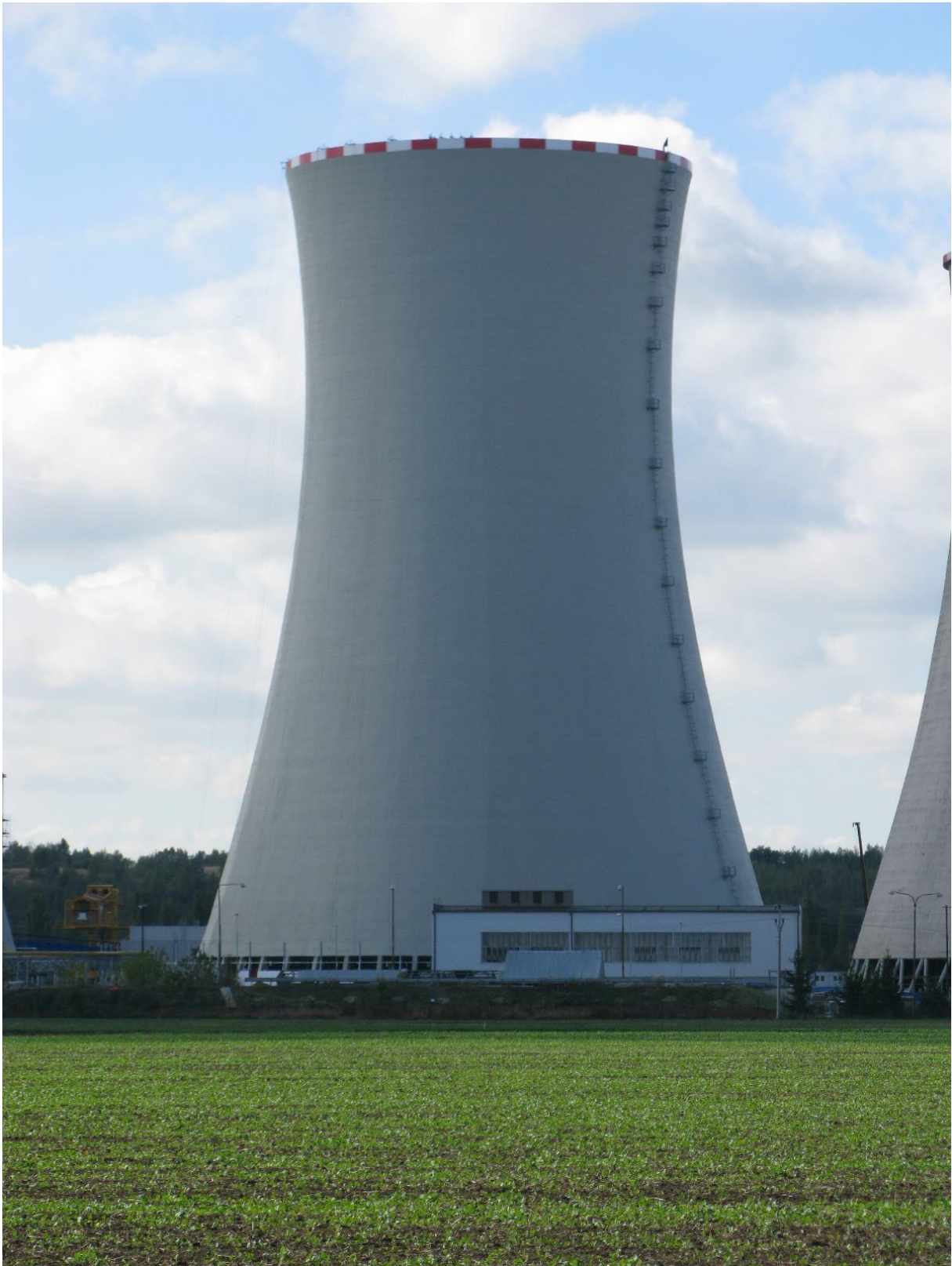
Рисунок 40 – Окончание строительства и передача в эксплуатацию
