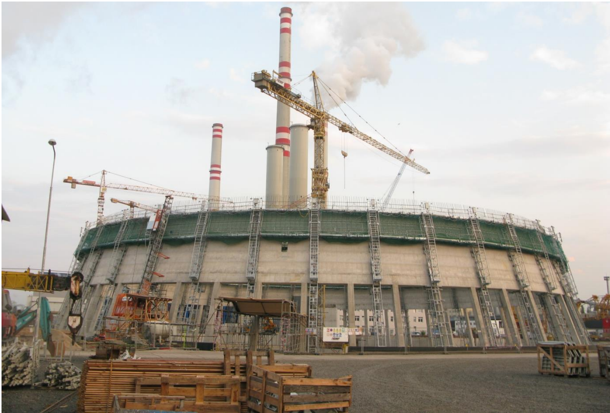
Рисунок 23 - Комплекс оборудования перед бетонированием 7 пояса
