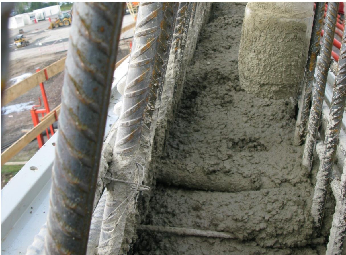
Рисунок 10 - Бетонирование первого пояса - деталь
