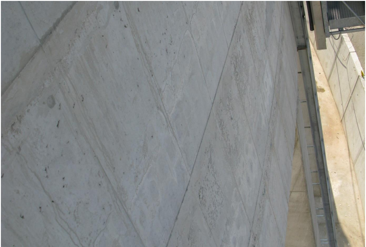
Рисунок 21 – Результатом процесса являются очень чистые бетонные поверхности
