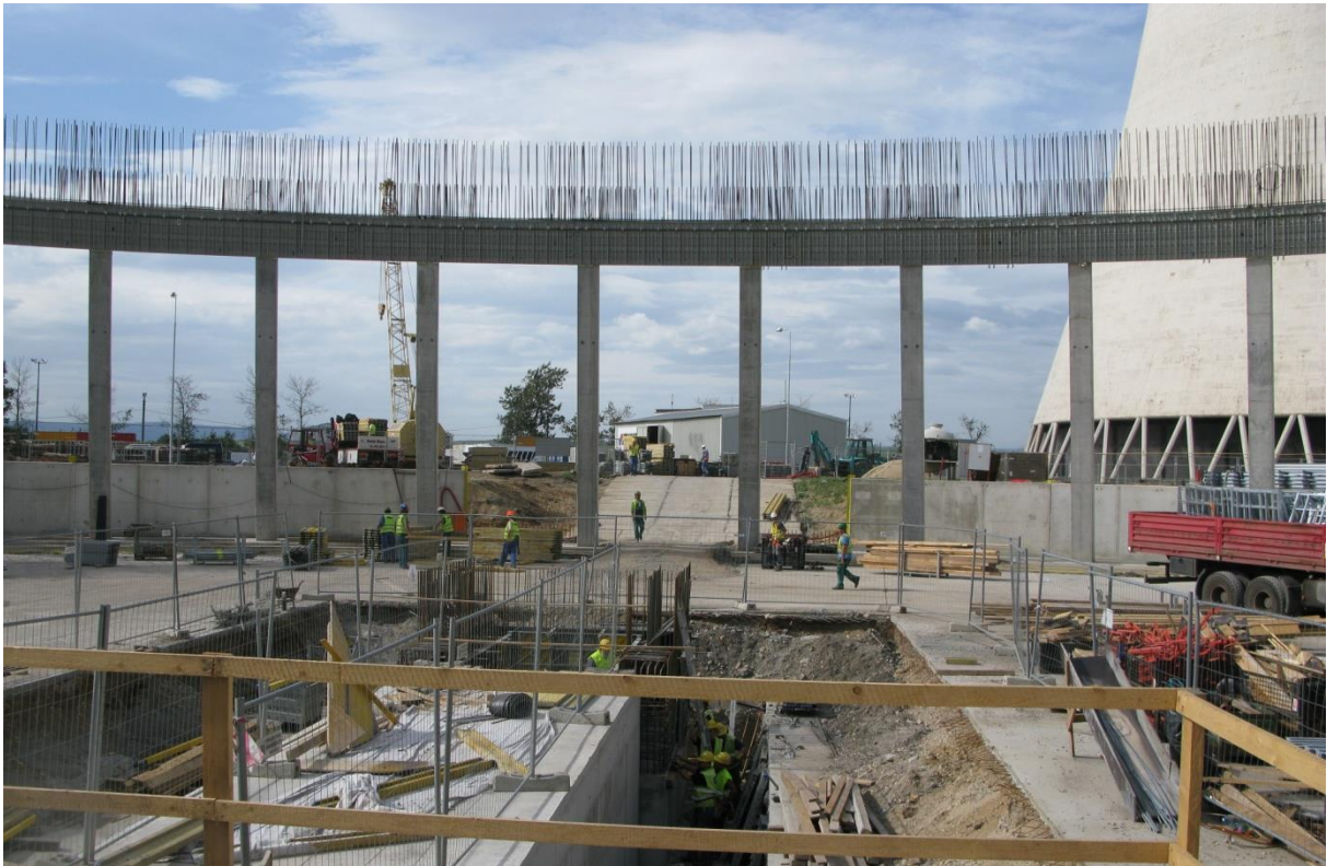
Рисунок 13 – Опорное крыло, подготовленное для подвешивания комплекса оборудования
