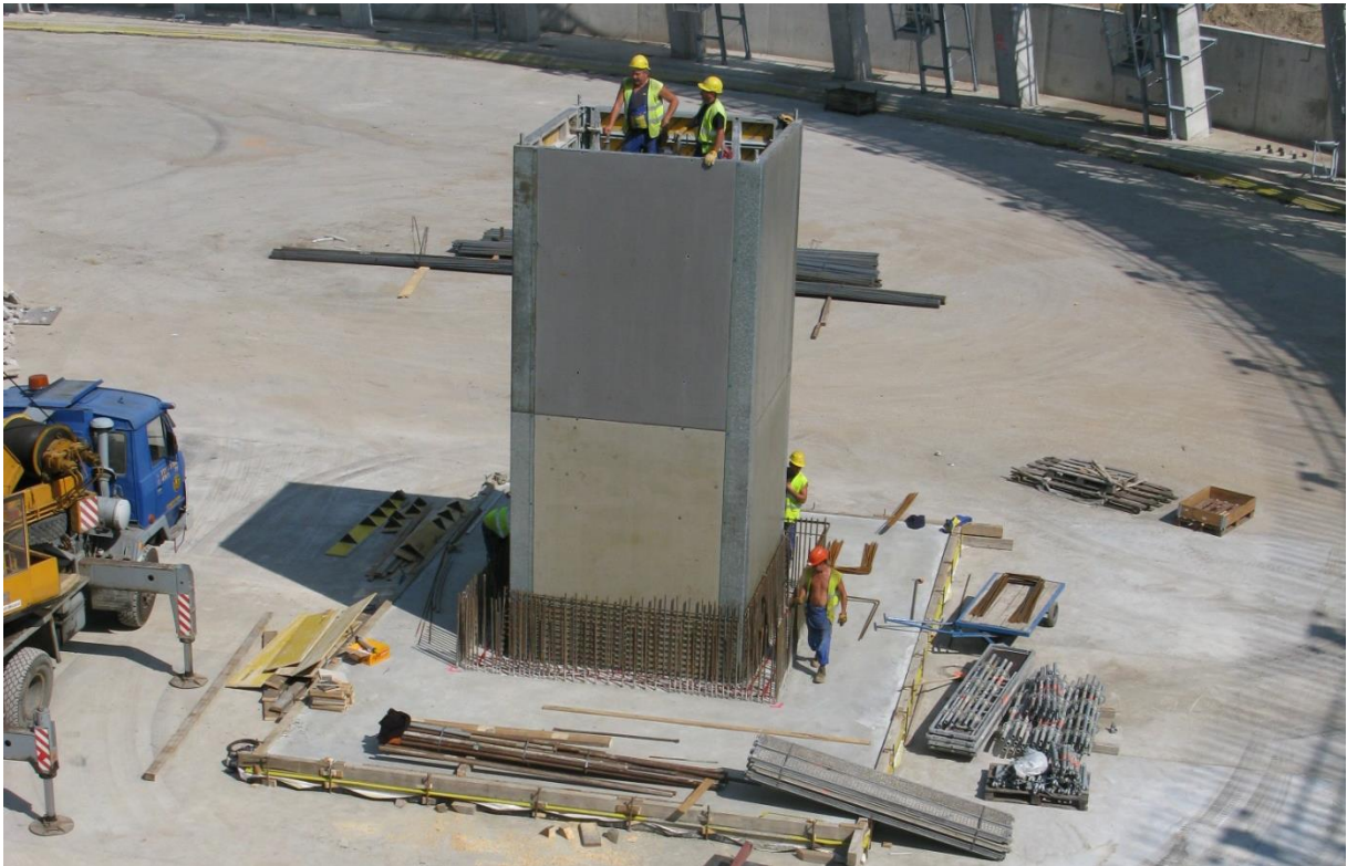
Рисунок 19 - Способ возведения подающего стояка
