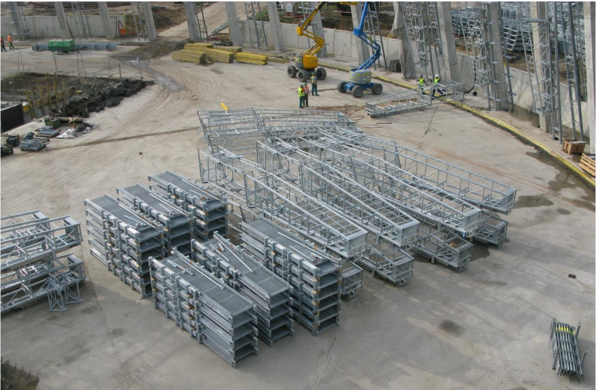
Рисунок 15 - Часть комплекса оборудования перед подвешиванием
