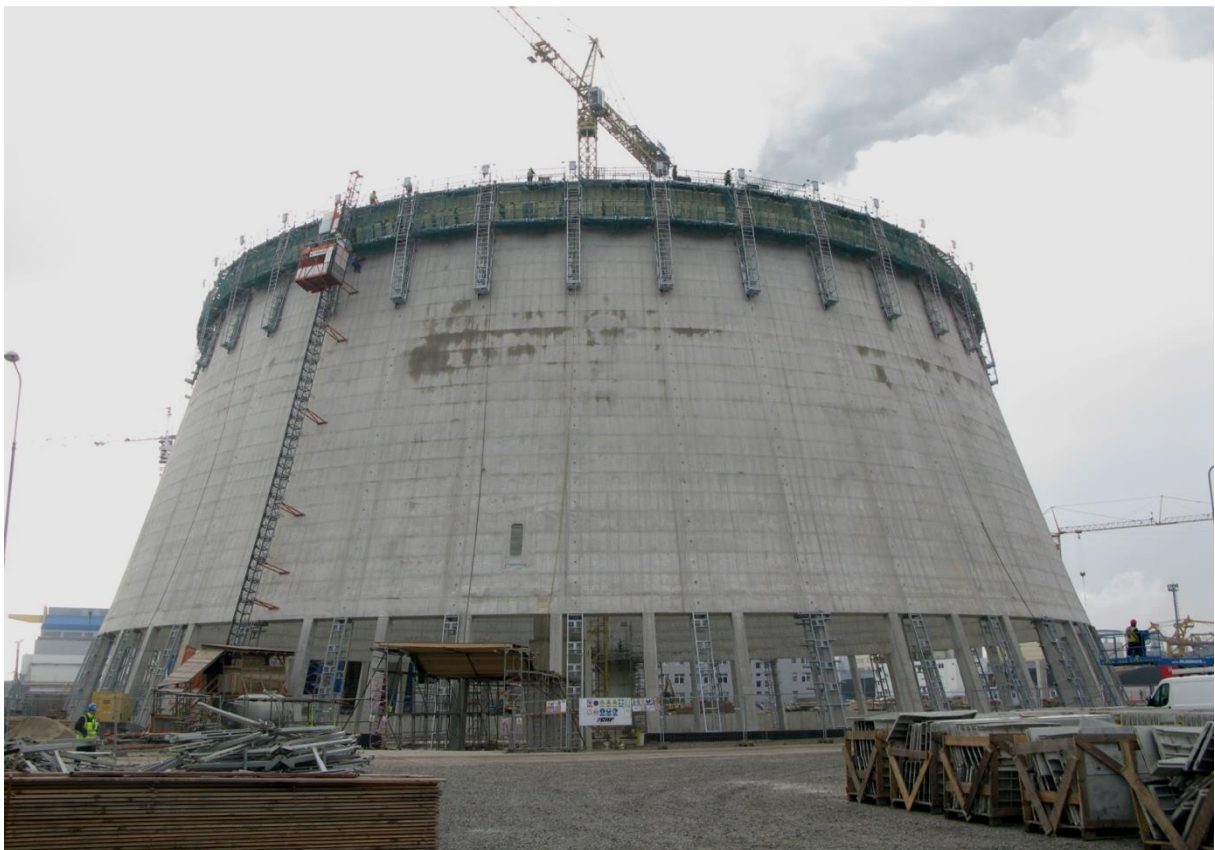
Рисунок 34 - Комплекс оборудования - вид на ориентацию рабочего лифта и временного въезда в градирню
