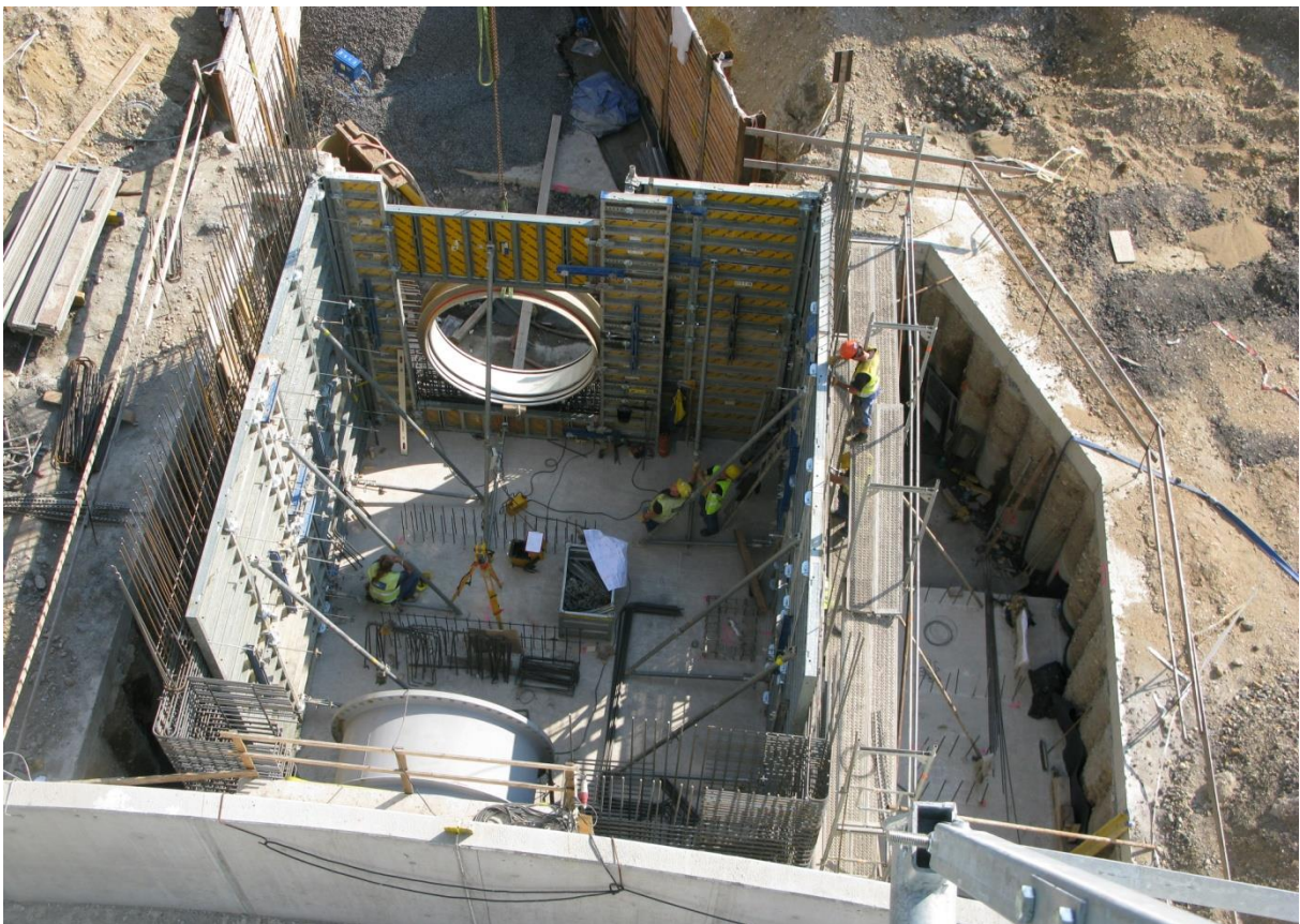
Рисунок 22 – Строительство арматурной камеры для установки запорной заслонки на подводящем канале
