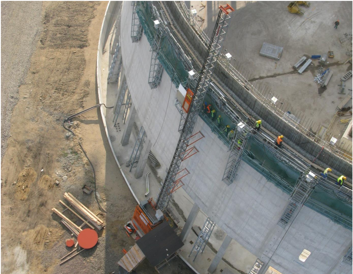
Рисунок 29 –Способ доставки рабочих на комплекс оборудования
