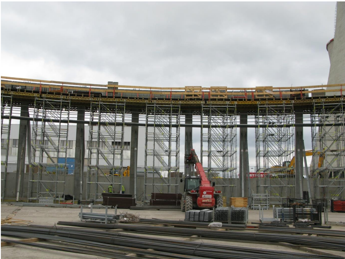
Рисунок 8 - Опалубка первого пояса
