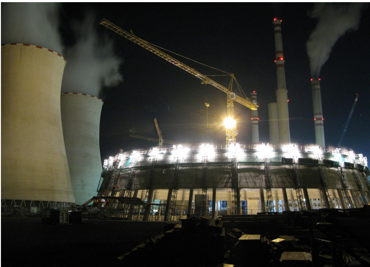
Рисунок 24 - Комплекс оборудования во время ночной смены - наружный венец
