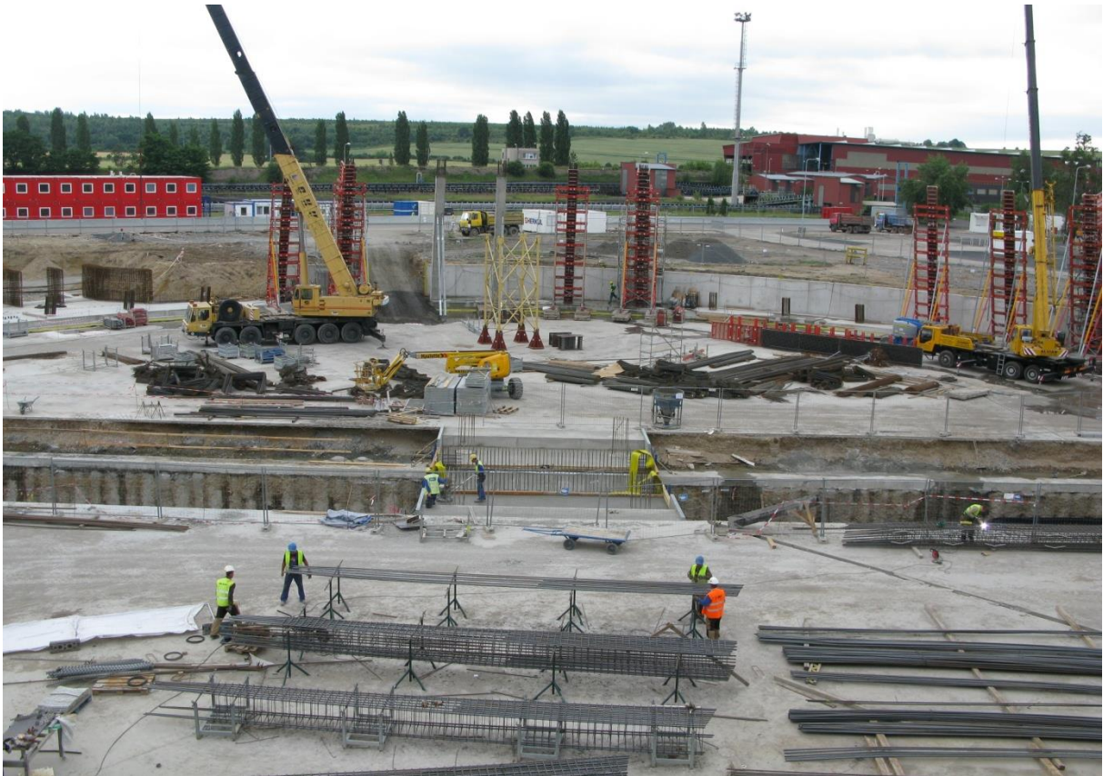
Рисунок 5 - Выполнение бетонирования наклонных стоек
