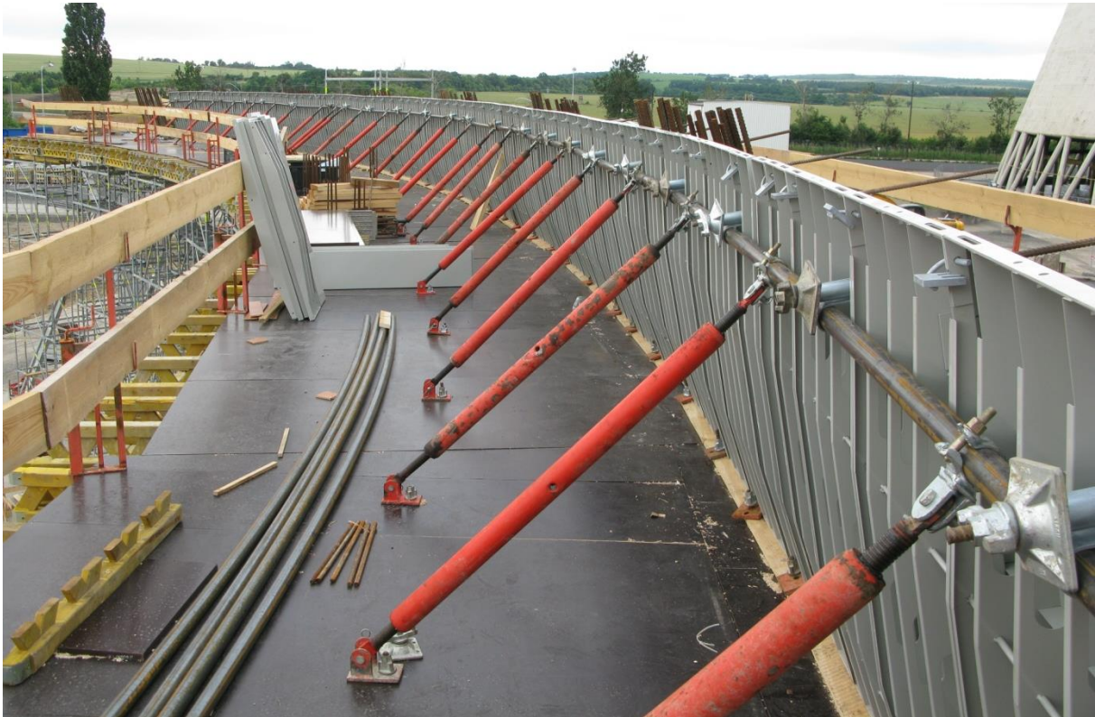
Рисунок 7 - Опалубка первого пояса (опорного крыла)
