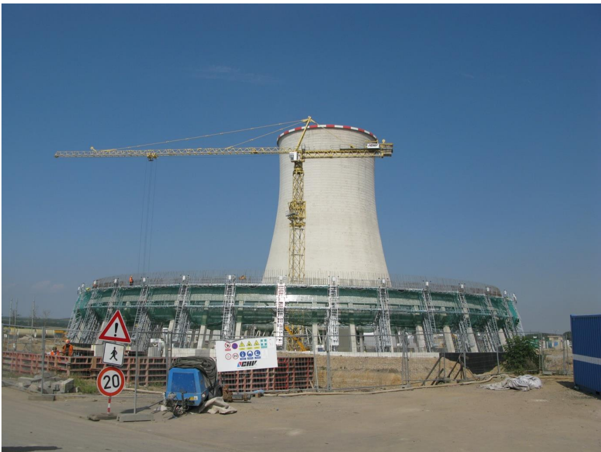
Рисунок 18 - Комплекс оборудования после окончания монтажа
