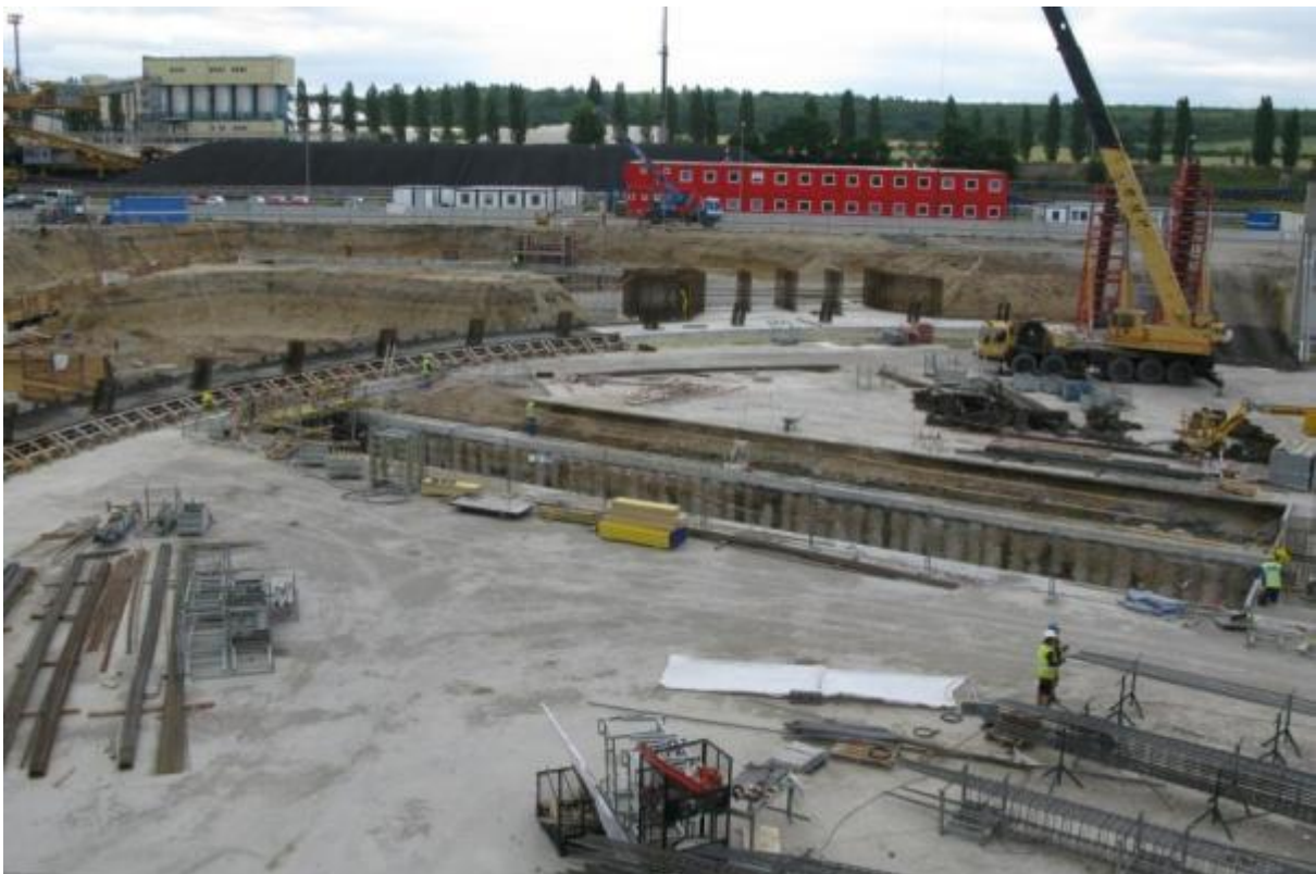
Рисунок 4 - Закладка наклонных стоек
