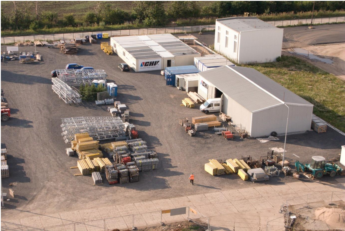
Рисунок 3 - Оборудование строительной площадки
