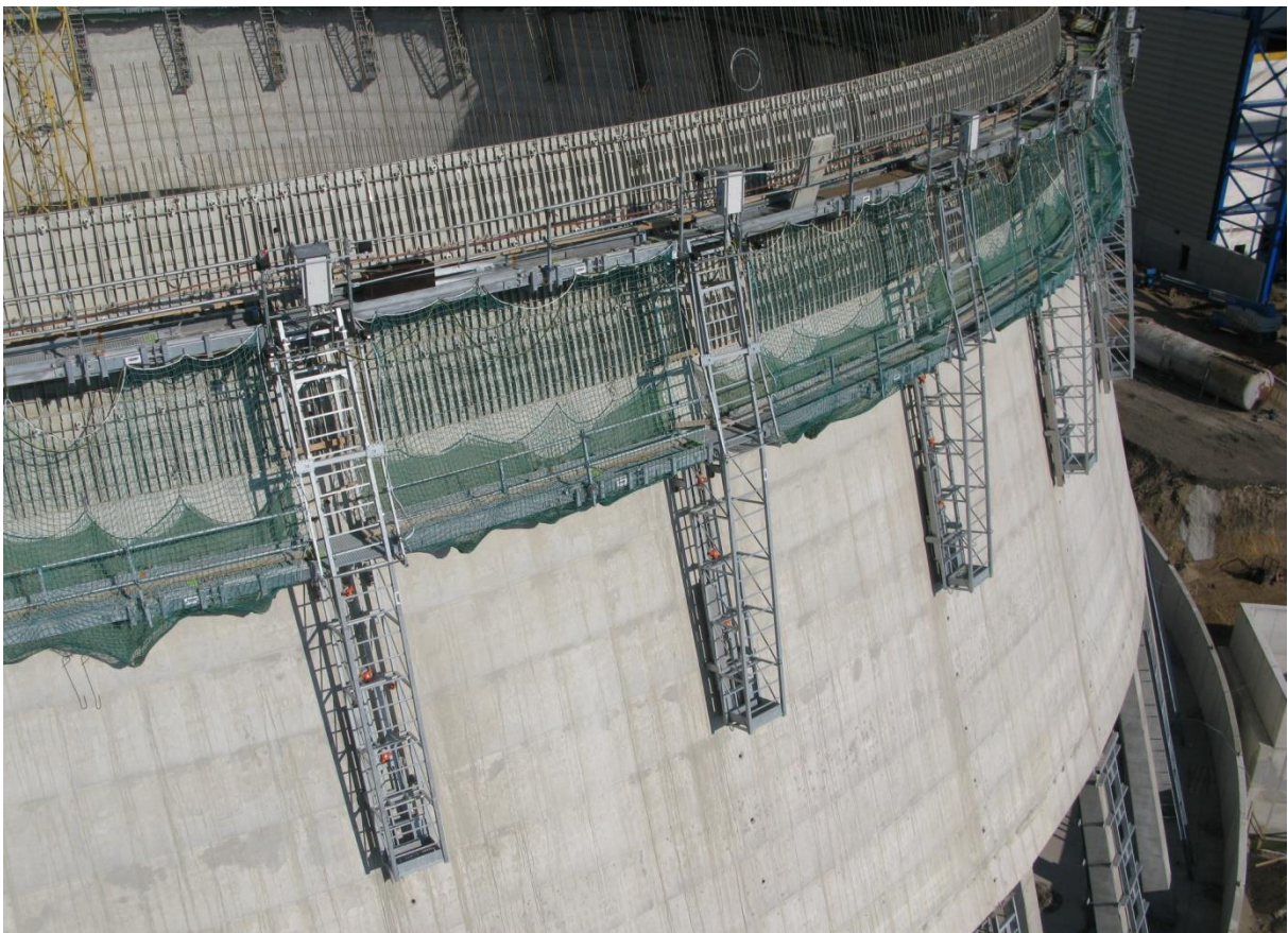
Рисунок 32 - Комплекс оборудования вместе с системой опалубки и установленными защитными сетями
