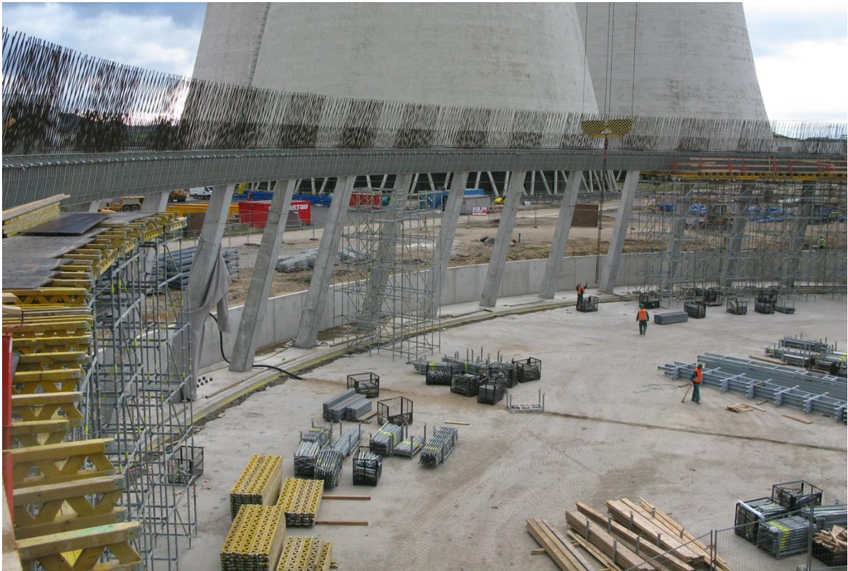
Рисунок 11 - Снятие подпорок первого пояса
