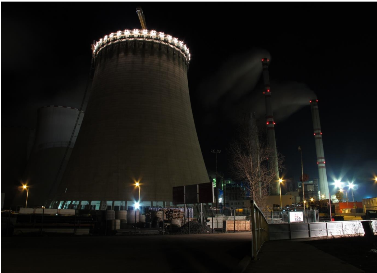
Рисунок 38 – Вид на комплекс оборудования и строительство ночью
