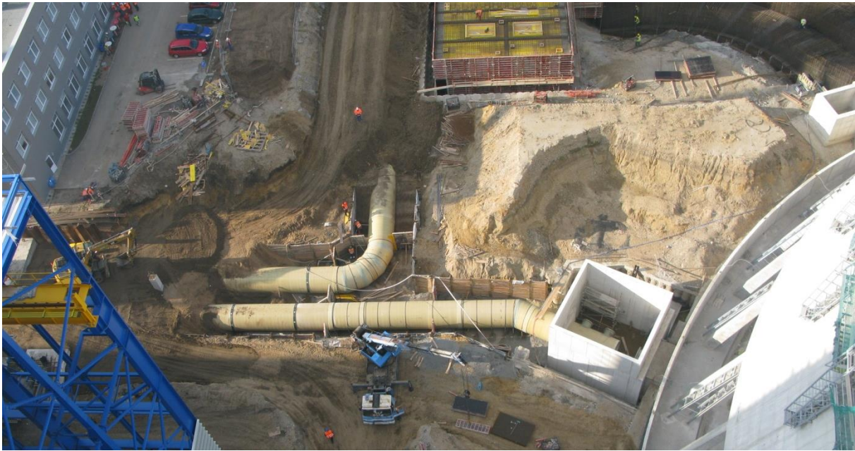
Рисунок 27 - Выполнение засыпки подводщих трубопроводов
