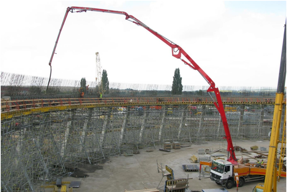
Рисунок 9 - Бетонирование первого пояса (опорного крыла)
