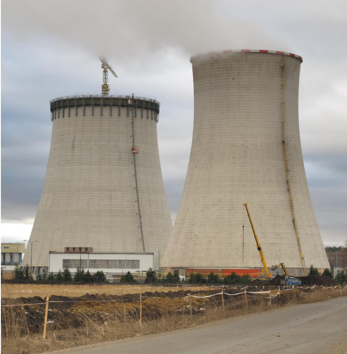
Рисунок 39 – Комплекс оборудования во время строительства
