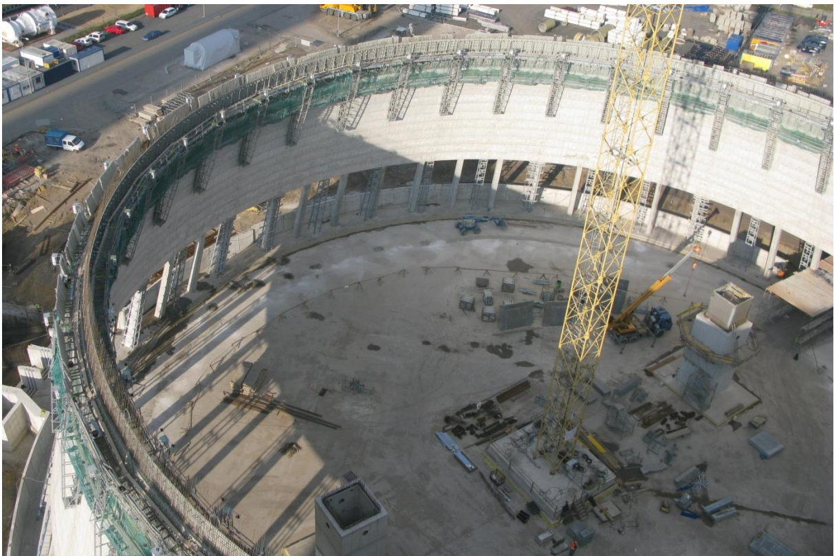
Рисунок 26 - Комплекс оборудования при бетонировании 15-го пояса - выполняется установка опалубки
