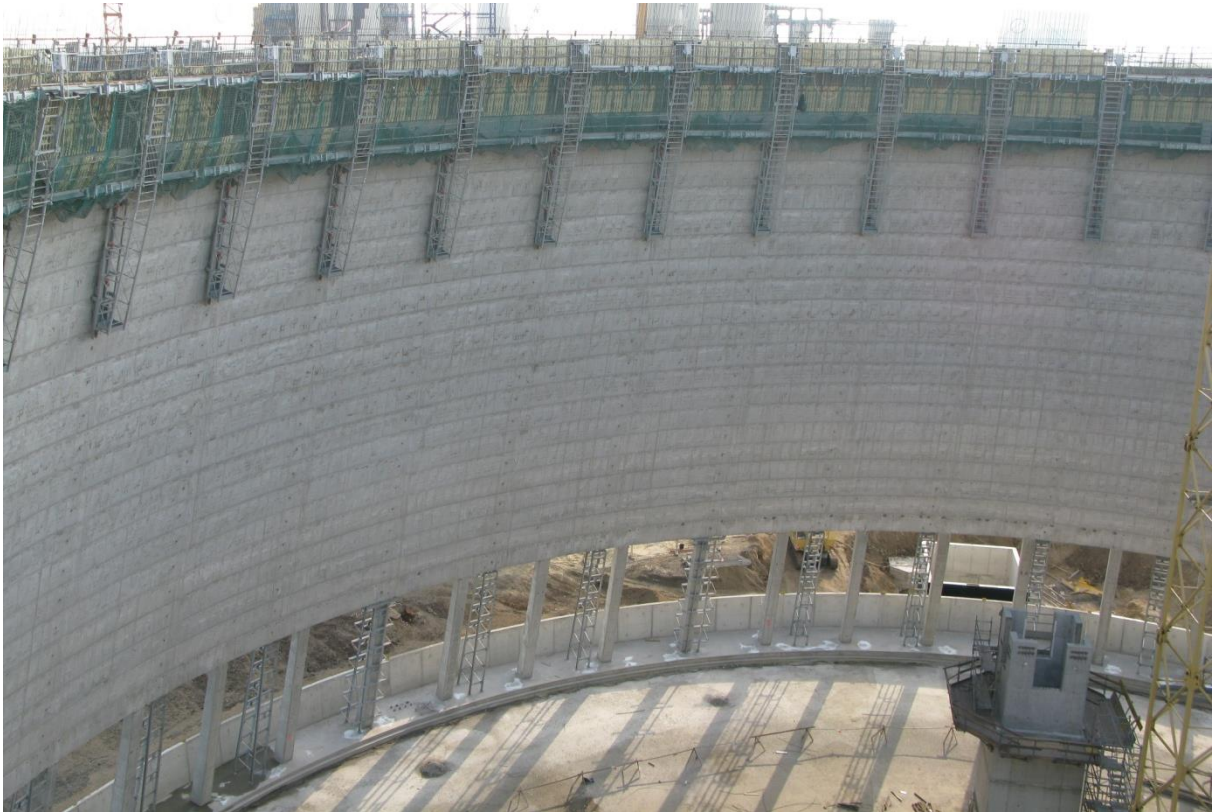
Рисунок 33 - Комплекс оборудования в зимний период
