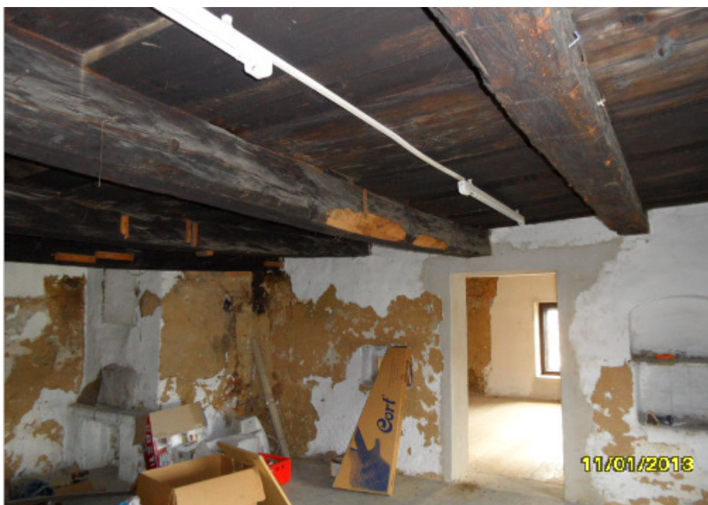
půdní prostor s hliněnou pecí nad hlavním traktem stavby
