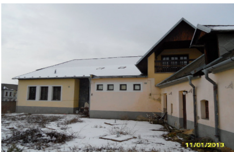
pohled od východu na objekt čp. 90, obec Tlumačov, okres Zlín
