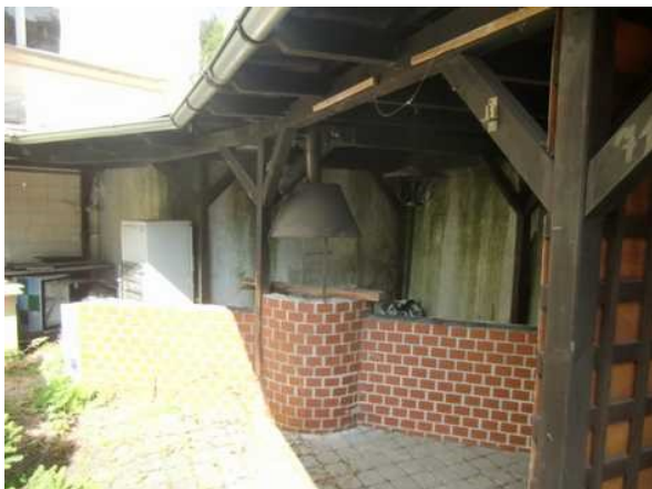
Přístřešek venkovního grilu
