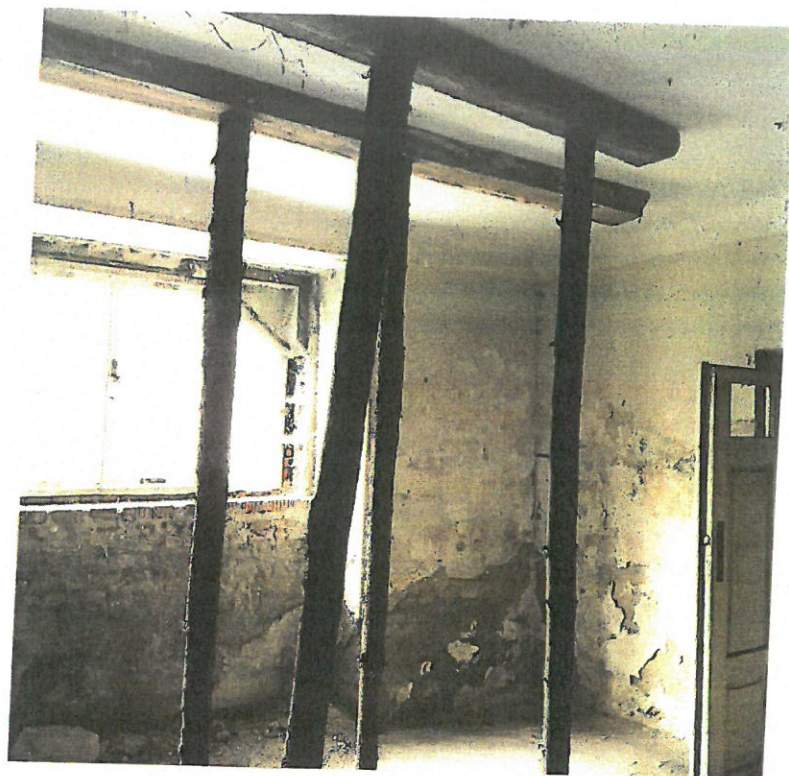
6.32np – zatékání, degradace zhlaví dřevěných trámů
