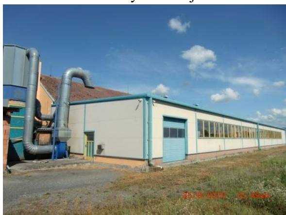
Hlavní výrobní objekt - boční přístavby
