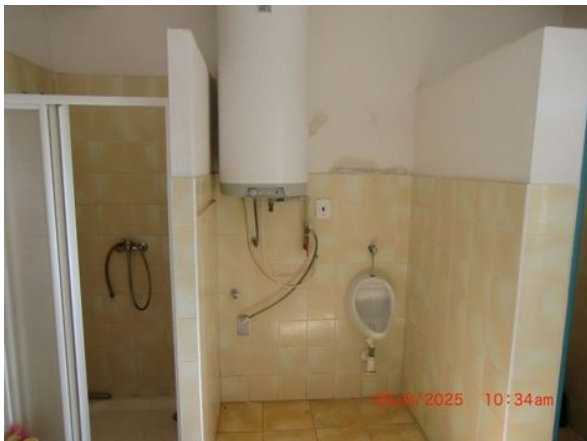
Interiér soc. zázemí
