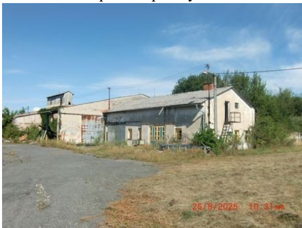
Zemědělská stavba bez čp/če (parc.č. St. 1181/1)
