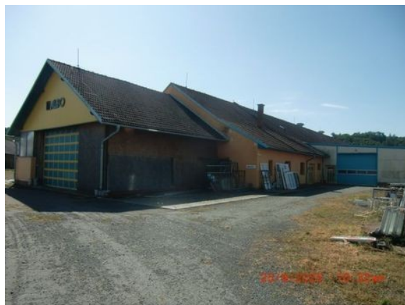
Hlavní výrobní objekt
