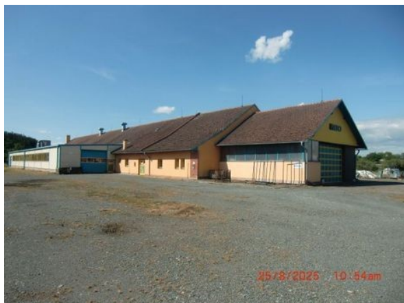
Hlavní výrobní objekt
