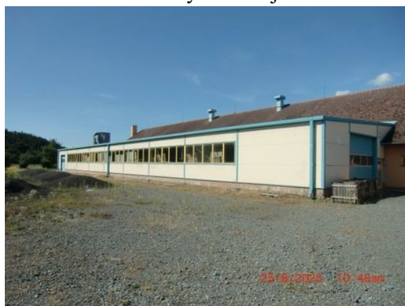
Hlavní výrobní objekt - boční přístavby
