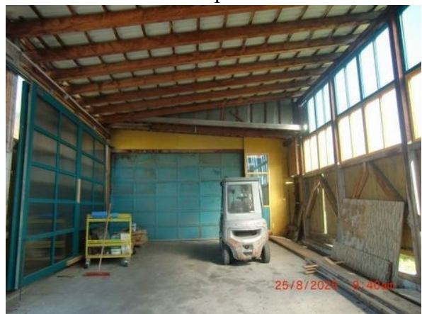
Výrobní a skladová hala I.
