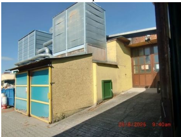
Výrobní a skladová hala I.
