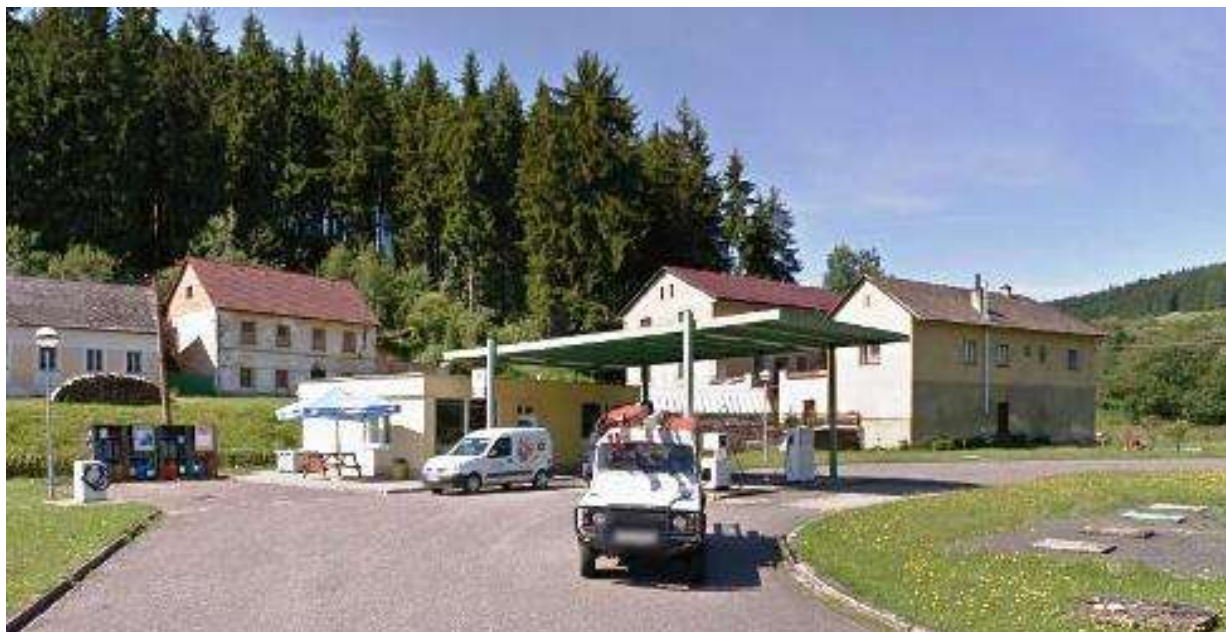
Foto objektu čerpací stanice PHM Jimramov :
