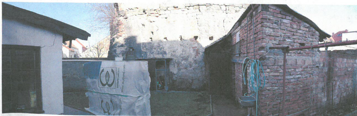
Dvorní část se zděnou kůlnou – kurníkem a městskými hradbami
