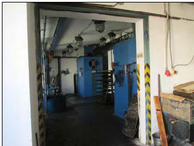
Foto č. 26 : Interiér výrobních ploch – impregnace
