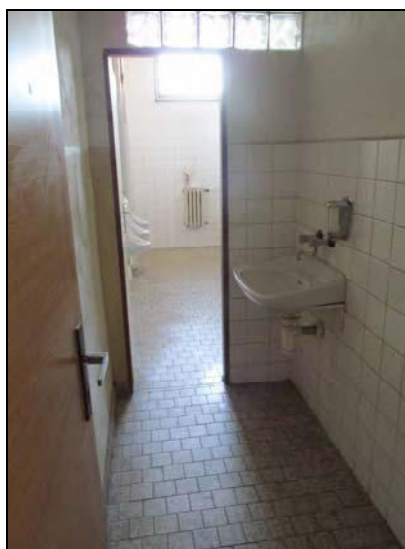
Foto č. 22 : Interiér sociálně provozní budovy - šatny
