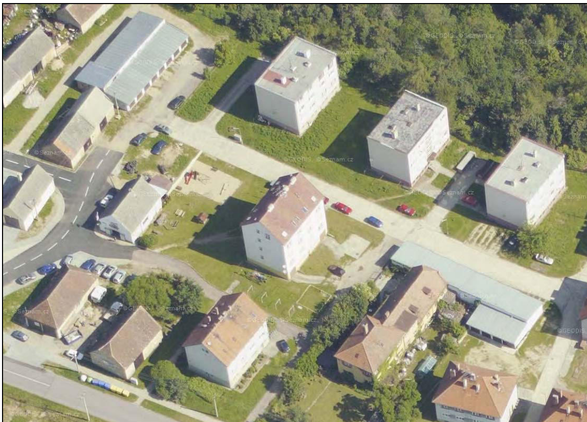
Bytový dům č. pop. 368 s pozemky
