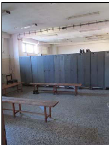
Foto č. 23 : Interiér sociálně provozní budovy - šatny
