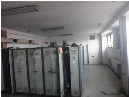
Administrativní část objektu - šatny
