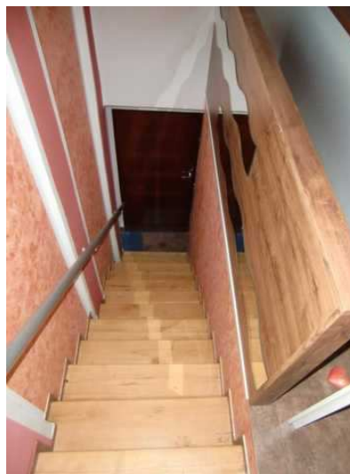
schodiště do bytu – z 1.NP
