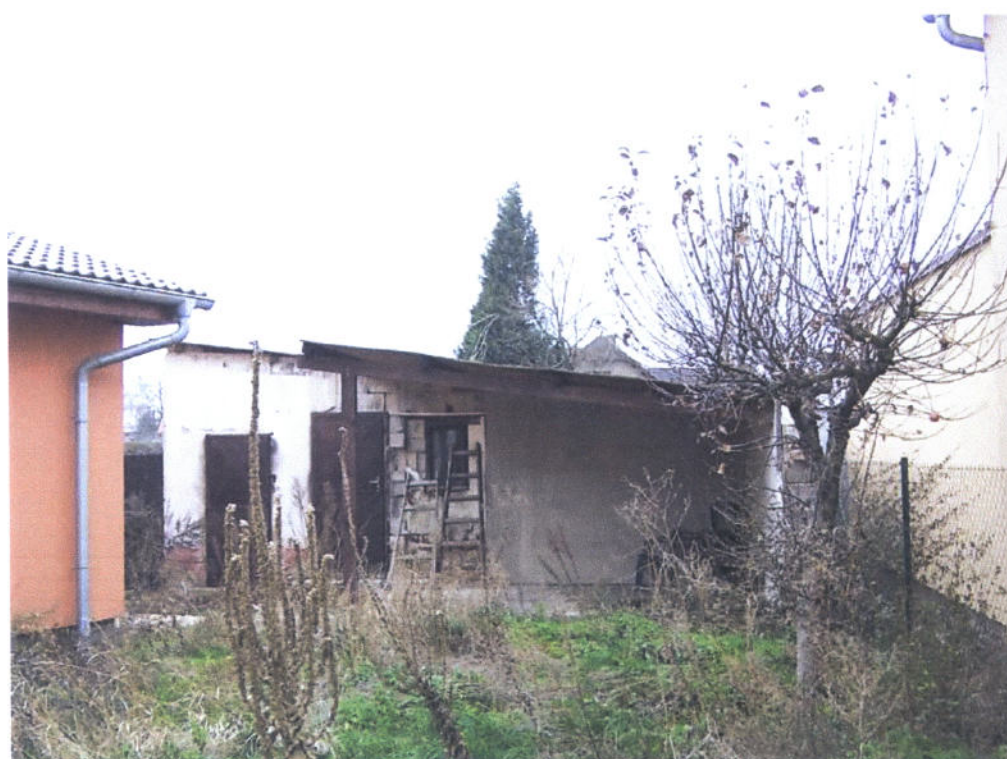
Kolna s přístřeškem
