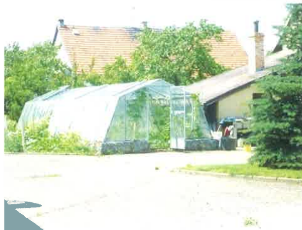
skleník a kotelna
