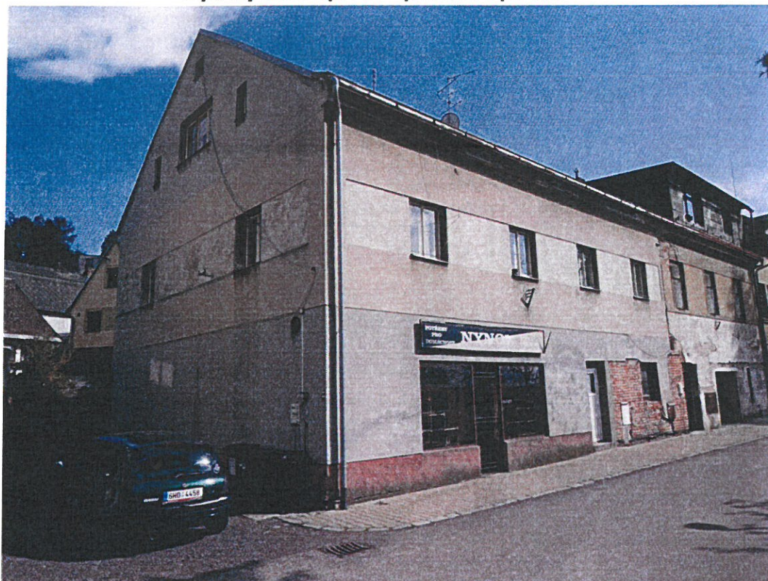
Bytový dům čp. 12 – pohled z předu
