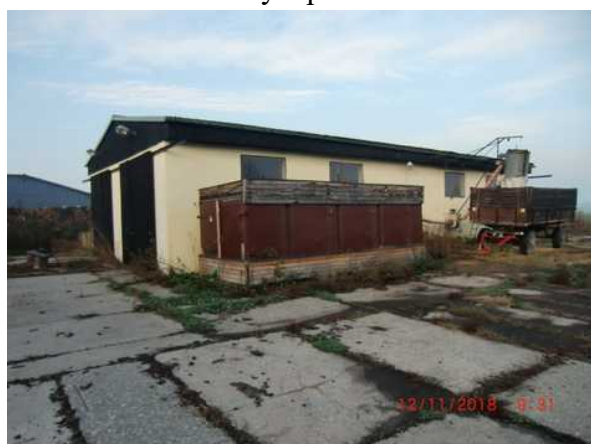
jiná stavba bez čp/če - pila (katrovná)
