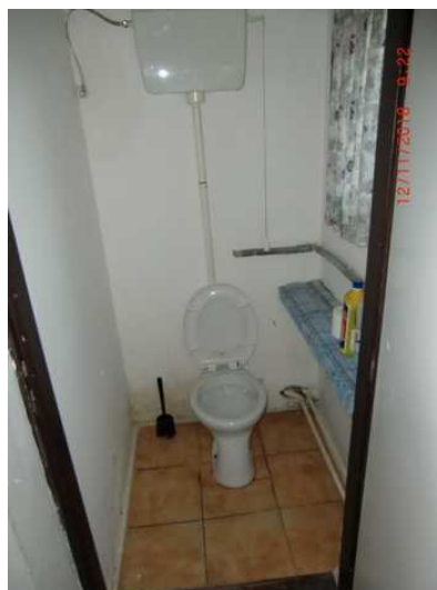
interiér budovy č.p. 103 - WC
