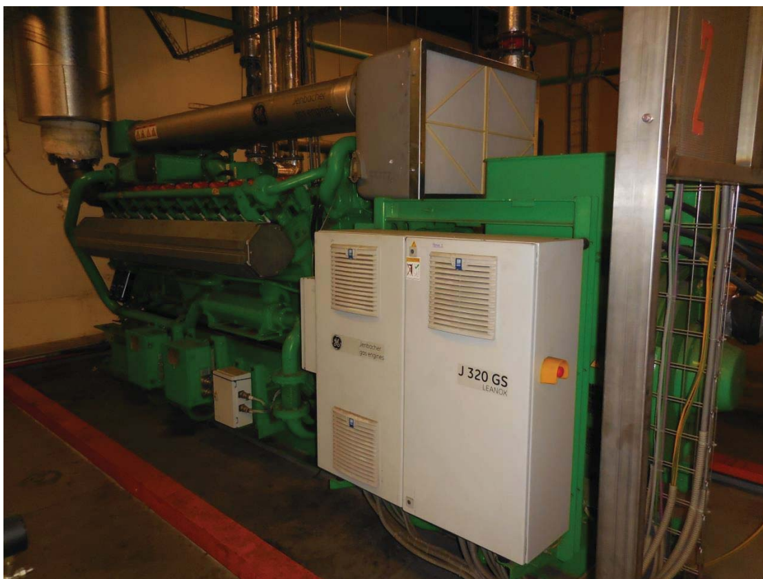
Obr. 6 Motor a generátor kogenerační jednotky
