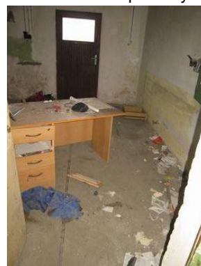
SO 02 vnitřní prostory
