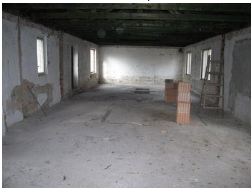
SO 01 vnitřní prostory
