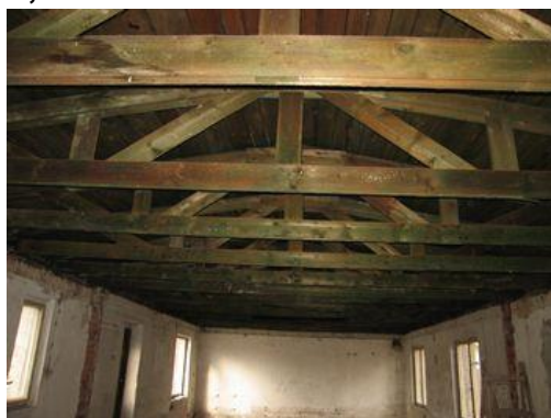
SO 01 demontované stropy
