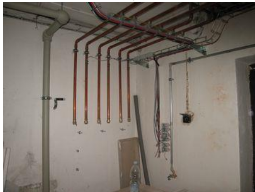
propojení ÚT pro tepl.čerpadlo
