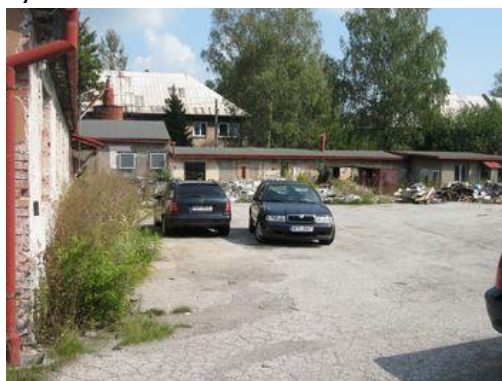
nádvoří, v pozadí budova SO 01
