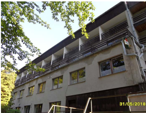
levé křídlo stavby
