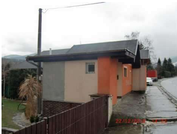
část č.p. 663 - pohled z ulice
