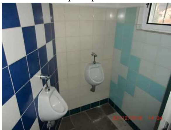
část č.p. 663 - interiér WC muži
