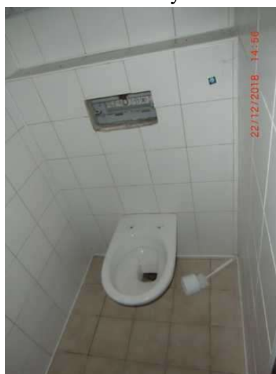
interiér WC v 1.PP
