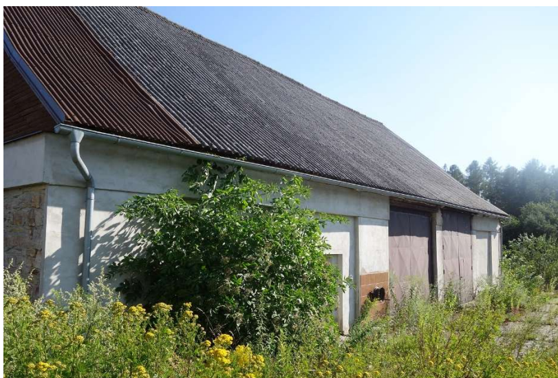
Pohled na budovu od severu
