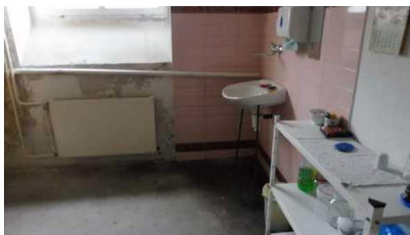
Sociální zázemí 1.PP administrativní budova
