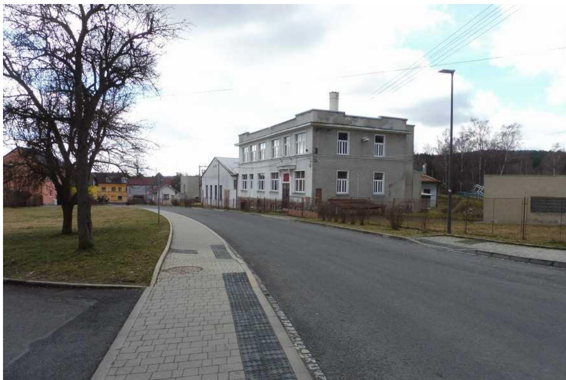
Celkový pohled na areál z ulice SV pohled
