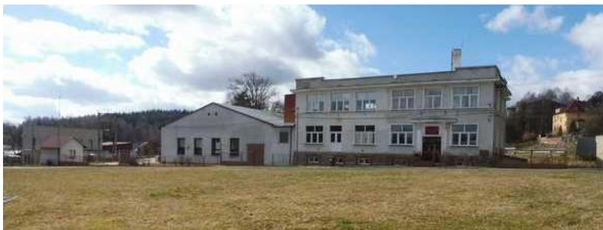
Celkový pohled na areál z ulice J pohled
