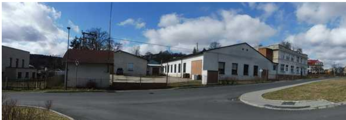
Celkový pohled na areál z ulice JV pohled
