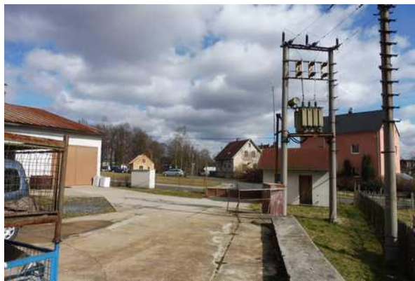
Vrátnice a trafostanice
