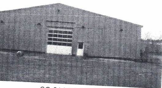
SO 01 hlavní hala
