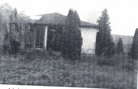
objekt bazénu na p.č. 1438-část
