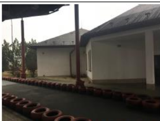
Nemovitá věc – pozemek p.č. st. 233, součástí je stavba bez čp/če – doprava, pohled zvenčí č. 6
