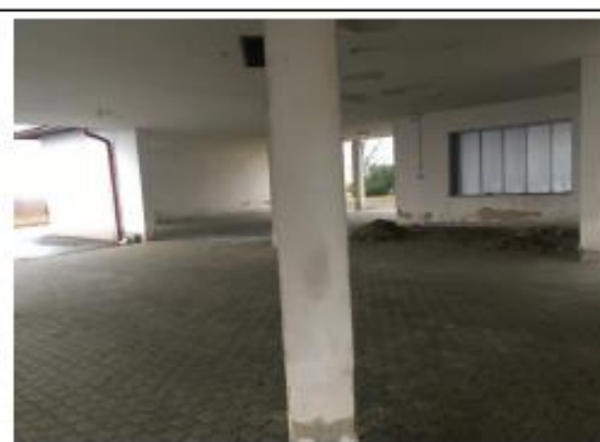
Nemovitá věc – pozemek p.č. st. 239, součástí je stavba bez čp/če – doprava, pohled vnitřní č. 2
