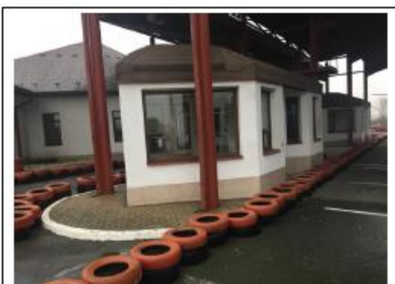
Nemovitá věc – pozemek p.č. st. 234, součástí je stavba bez čp/če – doprava, pohled zvenčí č. 3
