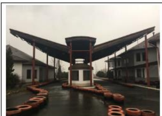
Nemovitá věc – pozemek p.č. st. 234, součástí je stavba bez čp/če – doprava, pohled zvenčí č. 2
