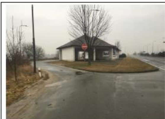
Nemovitá věc – pozemek p.č. st. 239, součástí je stavba bez čp/če – doprava, pohled zvenčí č. 1
