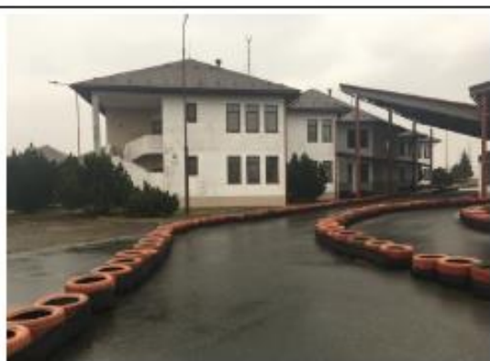
Nemovitá věc – pozemek p.č. st. 236, součástí je stavba č.p. 10 – doprava, pohled zvenčí č. 3
