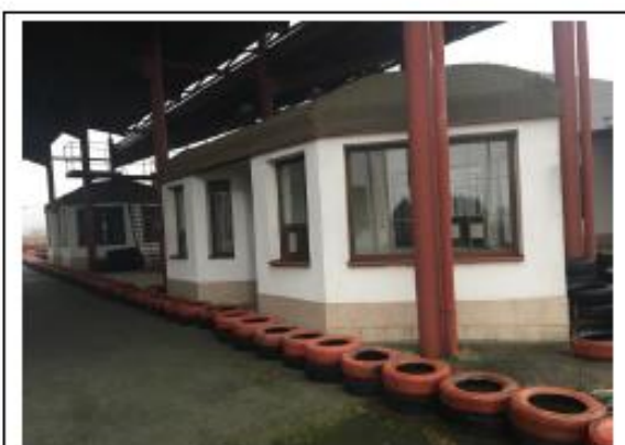
Nemovitá věc – pozemek p.č. st. 234, součástí je stavba bez čp/če – doprava, pohled zvenčí č. 5
