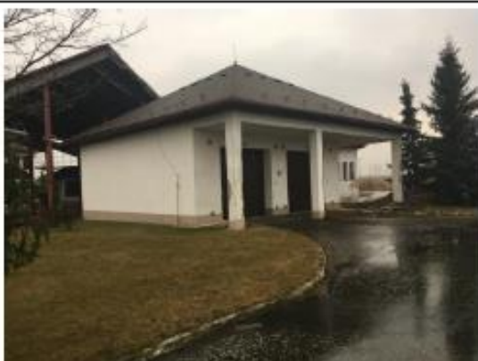
Nemovitá věc – pozemek p.č. st. 233, součástí je stavba bez čp/če – doprava, pohled zvenčí č. 1
