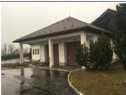
Nemovitá věc – pozemek p.č. st. 233, součástí je stavba bez čp/če – doprava, pohled zvenčí č. 5
