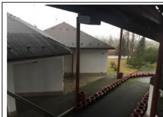
Nemovitá věc – pozemek p.č. st. 233, součástí je stavba bez čp/če – doprava, pohled zvenčí č. 8
