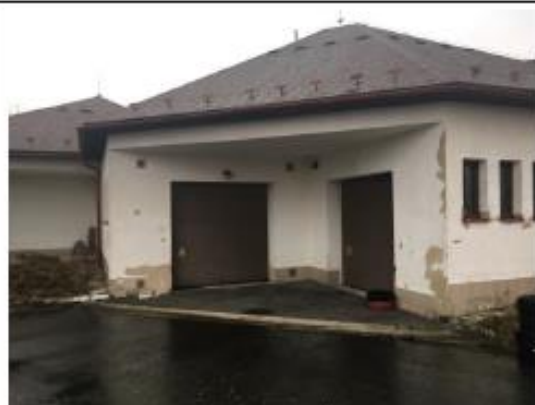
Nemovitá věc – pozemek p.č. st. 233, součástí je stavba bez čp/če – doprava, pohled zvenčí č. 2
