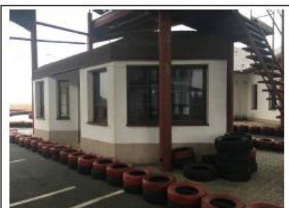
Nemovitá věc – pozemek p.č. st. 234, součástí je stavba bez čp/če – doprava, pohled zvenčí č. 4
