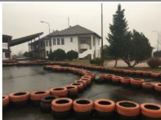
Nemovitá věc – pozemek p.č. st. 236, součástí je stavba č.p. 10 – doprava, pohled zvenčí č. 2
