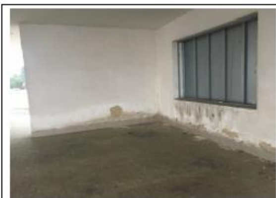
Nemovitá věc – pozemek p.č. st. 239, součástí je stavba bez čp/če – doprava, pohled vnitřní č. 1
