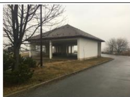
Nemovitá věc – pozemek p.č. st. 239, součástí je stavba bez čp/če – doprava, pohled zvenčí č. 4
