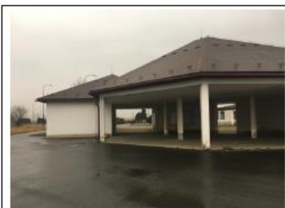
Nemovitá věc – pozemek p.č. st. 239, součástí je stavba bez čp/če – doprava, pohled zvenčí č. 3
