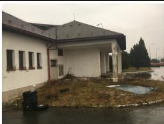
Nemovitá věc – pozemek p.č. st. 233, součástí je stavba bez čp/če – doprava, pohled zvenčí č. 4
