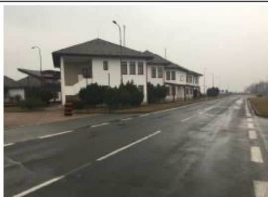
Nemovitá věc – pozemek p.č. st. 236, součástí je stavba č.p. 10 – doprava, pohled zvenčí č. 1
