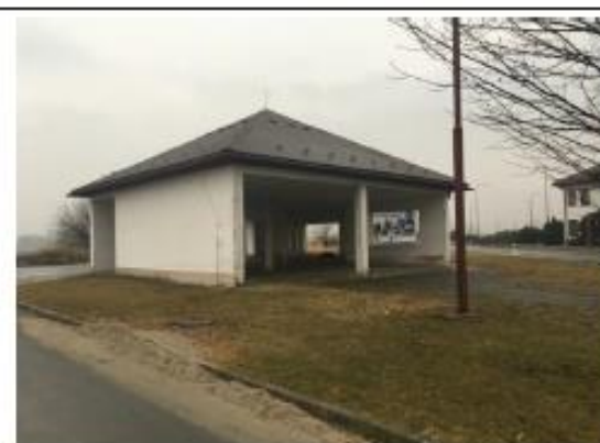
Nemovitá věc – pozemek p.č. st. 239, součástí je stavba bez čp/če – doprava, pohled zvenčí č. 2
