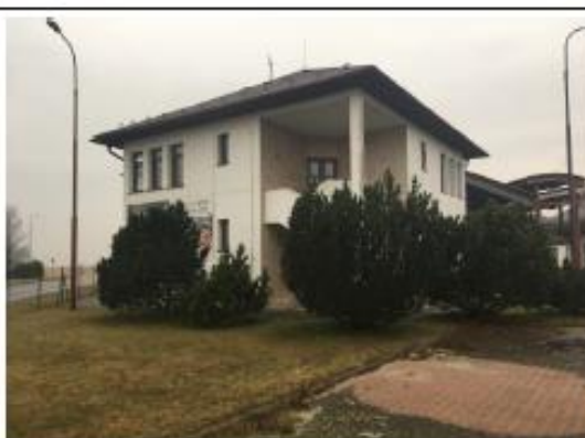
Nemovitá věc – pozemek p.č. st. 236, součástí je stavba č.p. 10 – doprava, pohled zvenčí č. 4
