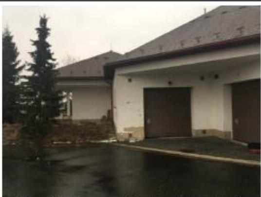
Nemovitá věc – pozemek p.č. st. 233, součástí je stavba bez čp/če – doprava, pohled zvenčí č. 3
