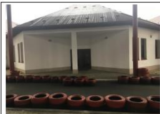
Nemovitá věc – pozemek p.č. st. 233, součástí je stavba bez čp/če – doprava, pohled zvenčí č. 7
