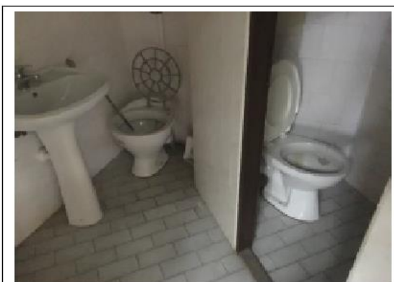
Nemovitá věc – pozemek p.č. st. 233, součástí je stavba bez čp/če – doprava, pohled vnitřní č. 3
