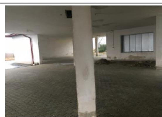
Nemovitá věc – pozemek p.č. st. 239, součástí je stavba bez ép/če – doprava, pohled vnitřní č. 2
