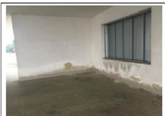
Nemovitá věc – pozemek p.č. st. 239, součástí je stavba bez ép/če – doprava, pohled vnitřní č. 1
