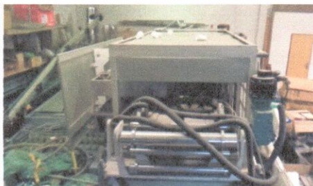
Obr. č. 7. Pohled na uložení technologické linky včetně obložení cizími předměty.
