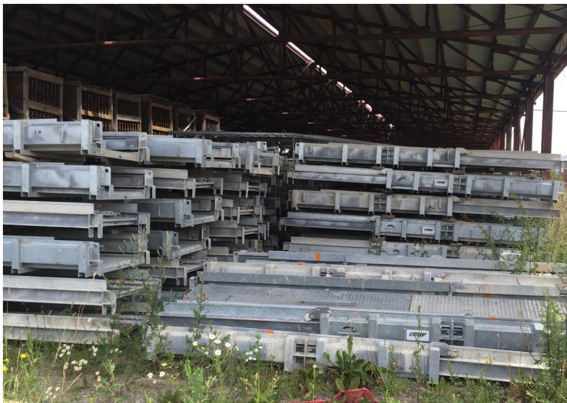
Рисунок 6 – Сохраненные площадки и части опалубок
