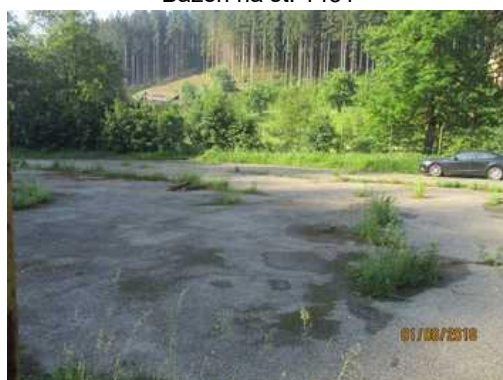
Zpevněná plocha na p.č. 4720/1
