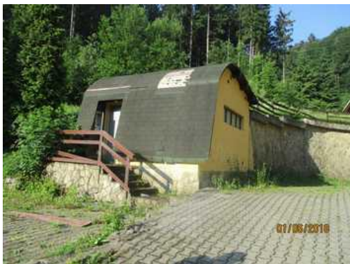
Vodárna na p.č. st. 848
