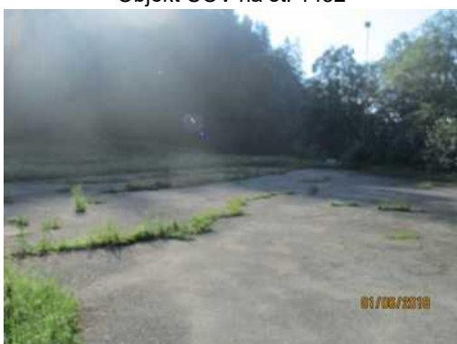
Zpevněná plocha na p.č. 4720/1
