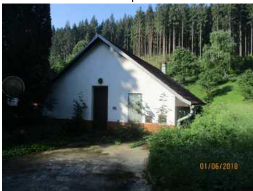
Objekt ČOV na st. 1452
