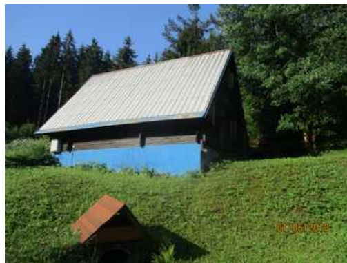
Objekt ČOV na st. 1452
