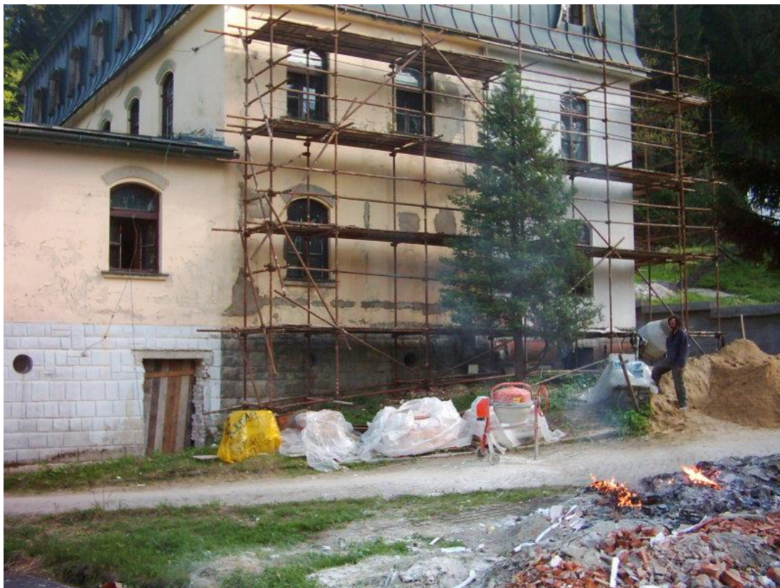
Foto č. 5 – Hlavní budova během rekonstrukce
