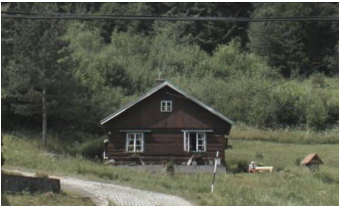
Foto č. 12 – exteriér, srubová chatka
