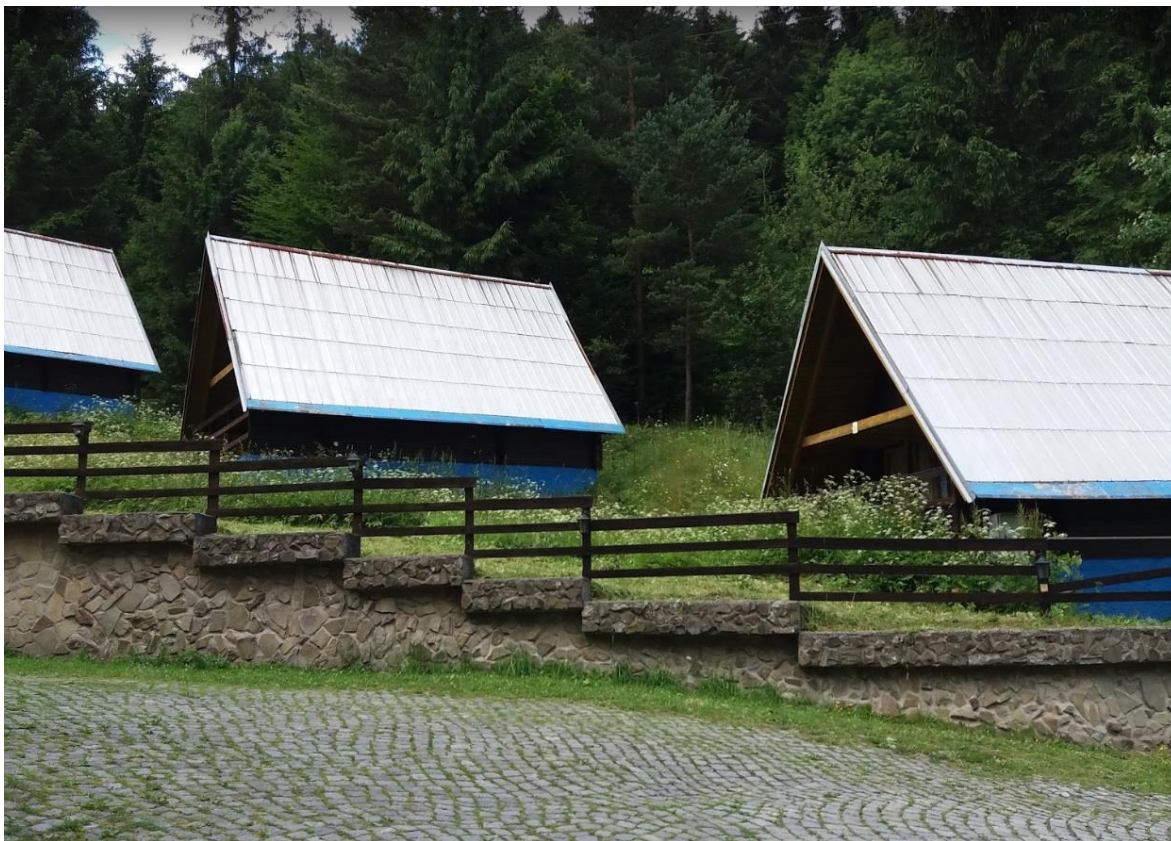
Foto č. 11 – exteriér, chatky
