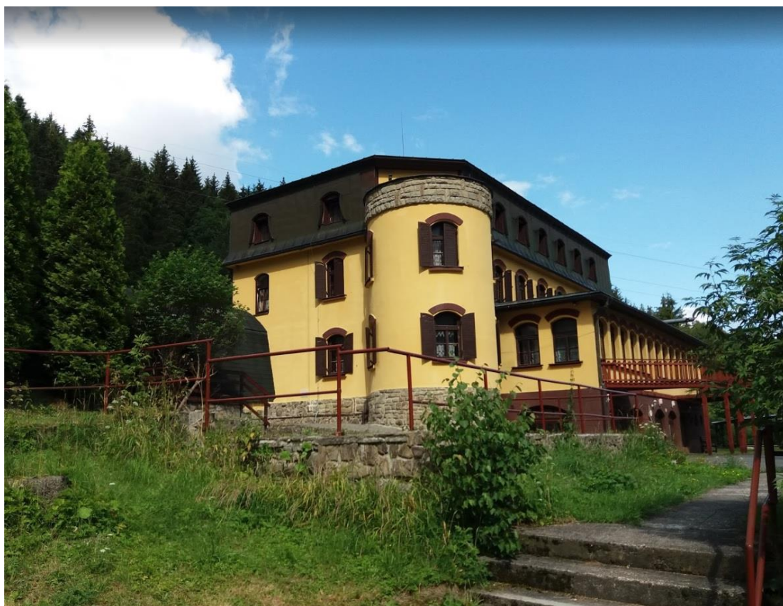
Foto č. 3 – Hlavní budova po rekonstrukci
