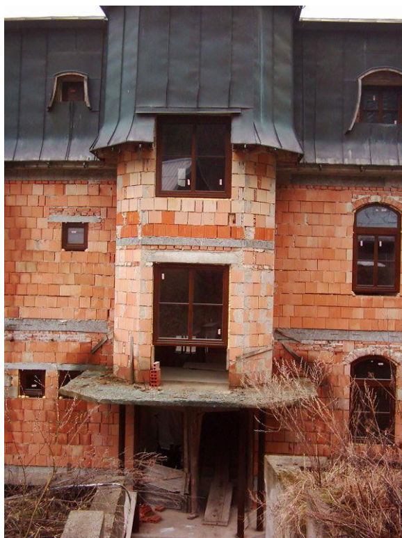
Foto č. 8 – Hlavní budova během rekonstrukce
