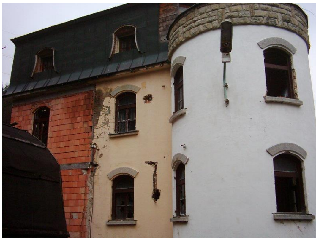
Foto č. 4 – Hlavní budova během rekonstrukce
