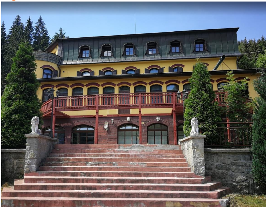
Foto č. 1 - Hlavní budova vstup
