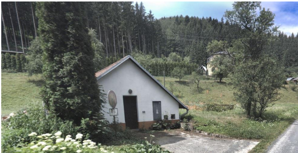
Foto č. 9 – ČOV
