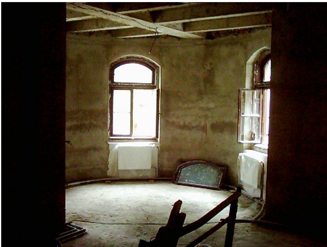
Foto č. 6 – Hlavní budova během rekonstrukce
