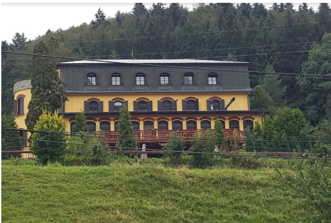
Foto č. 2 – Hlavní budova
