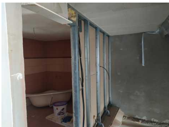
Pohled z chodby na koupelnu a prostor pro schodiště
