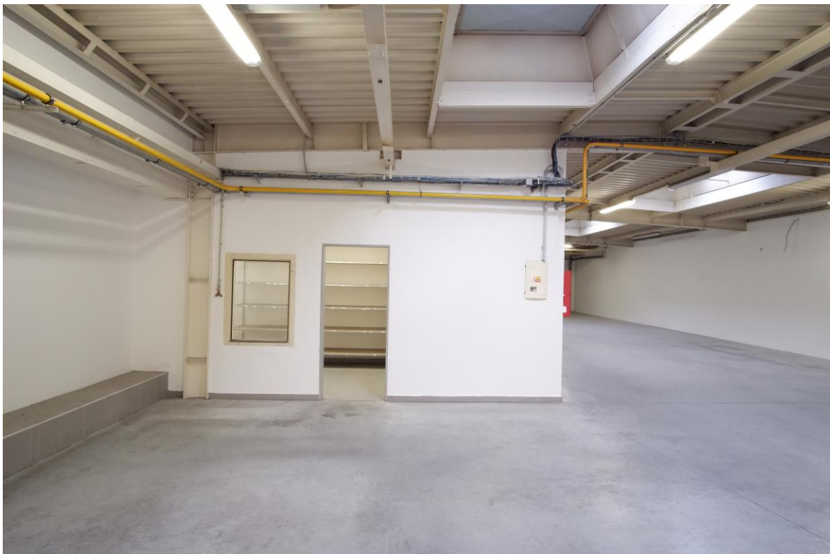
Obr. č. 21 - Výrobní a skladová hala č. 101, sklad (102)
