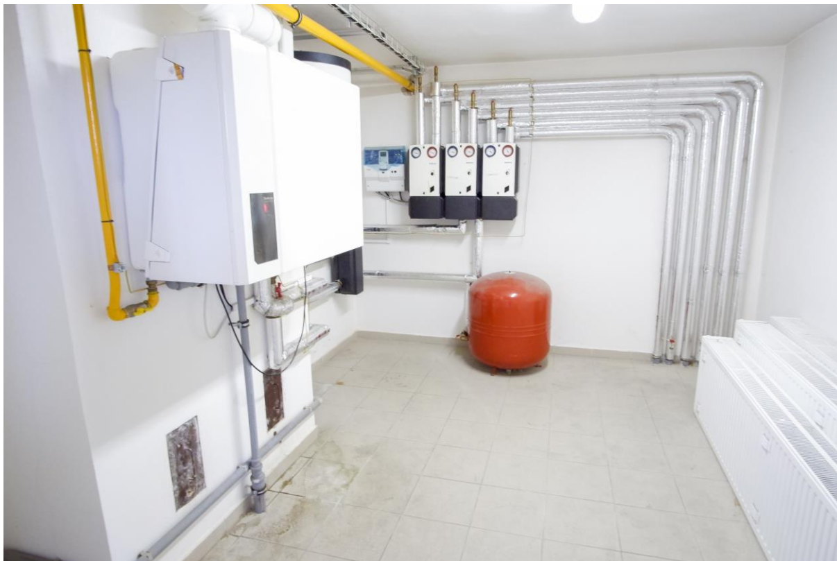
Obr. č. 7 – Výrobní a skladová hala č. 113, kotelna
