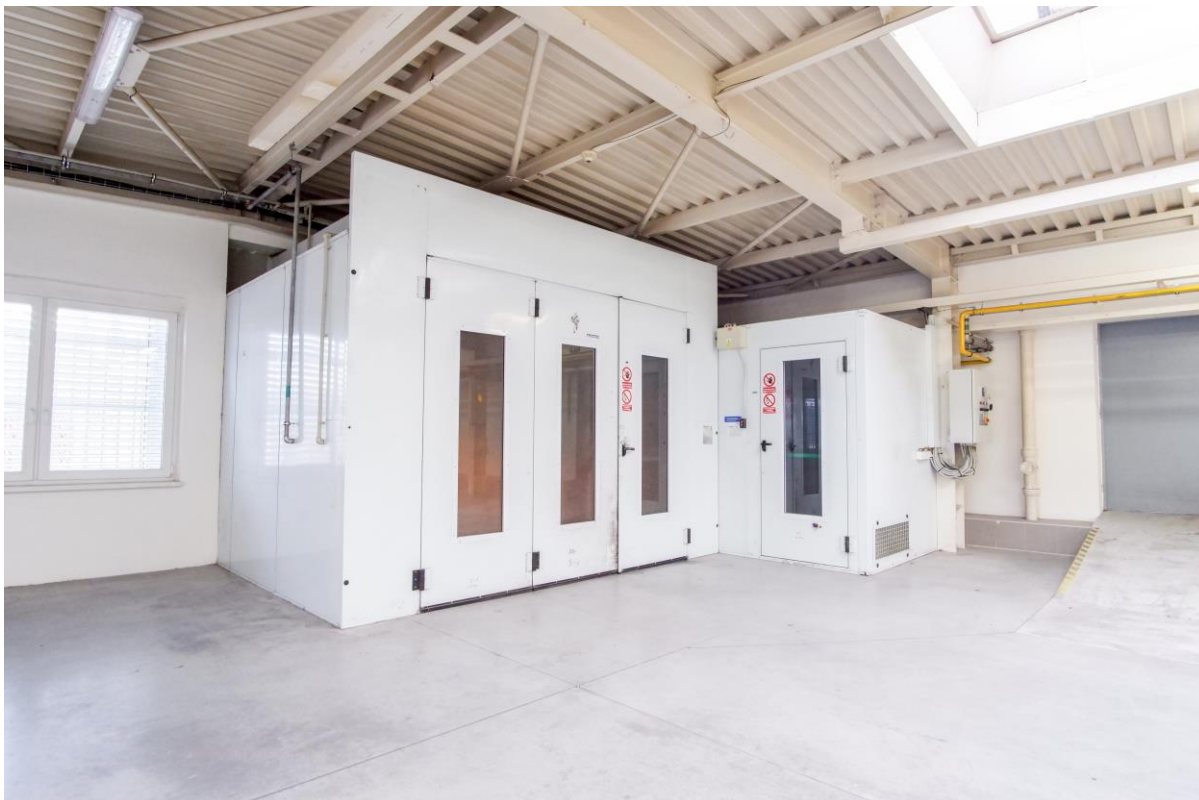
Obr. č. 19 - Výrobní a skladová hala č. 101, lakovna
