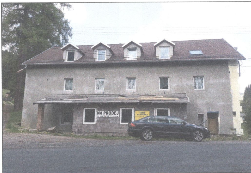
CELKOVÝ POHLED ZE SILNICE
