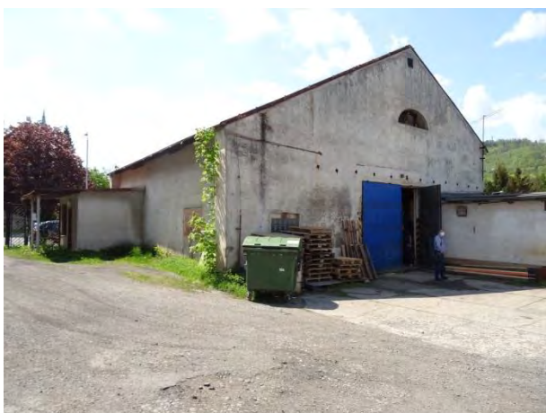
Budova skladu č. 2
