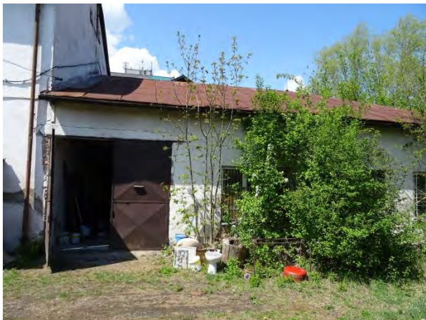
Budova skladu č. 1
