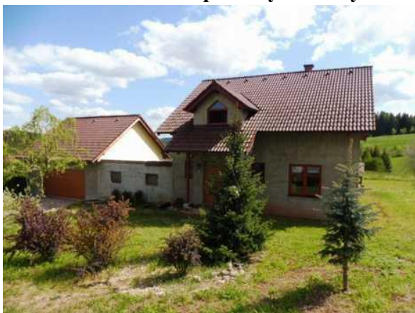
pohled z komunikace
