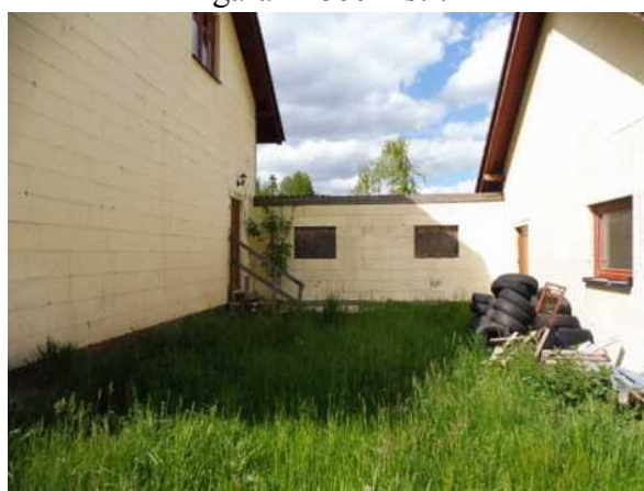
zeď mezi RD a garáží
