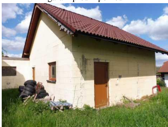
garáž - pohled ze dvora
