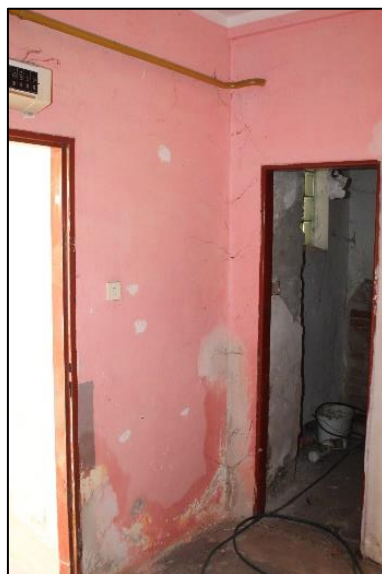
Obr. č. 12 - Interiér bytové jednotky v 1.NP
