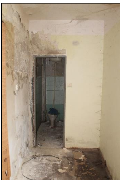
Obr. č. 9 - Interiér bytové jednotky v 1.NP
