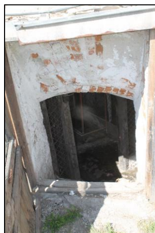
Obr. č. 22 - Sklepní prostory
