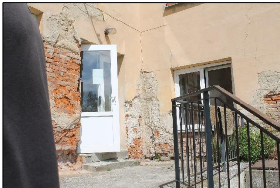
Obr. č. 5 – Boční vstup do domu - dvorní
