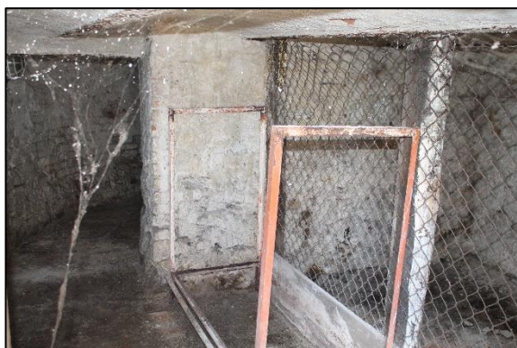
Obr. č. 21 – Sklepní prostory
