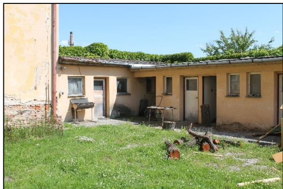
Obr. č. 4 – Vedlejší stavba skladovacích prostor
