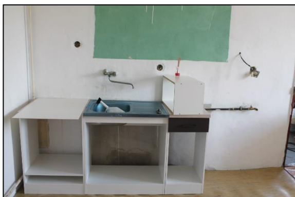
Obr. č. 17 – Interiér nově rekonstruované bytové jednotky v 2.NP
