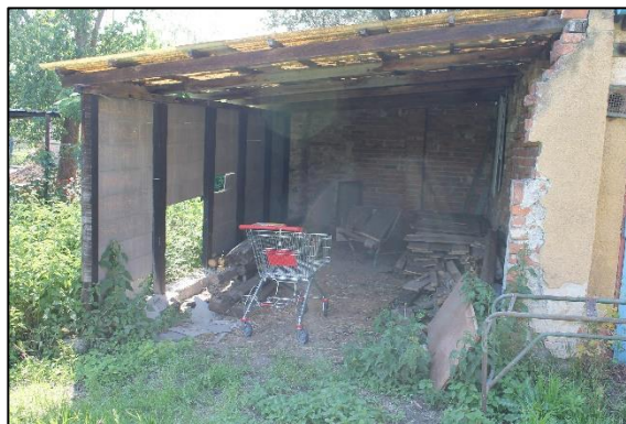
Obr. č. 24 – Přístřešek
