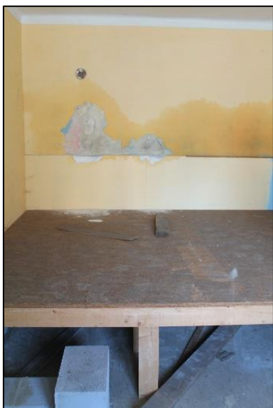
Obr. č. 11 - Interiér bytové jednotky v 1.NP
