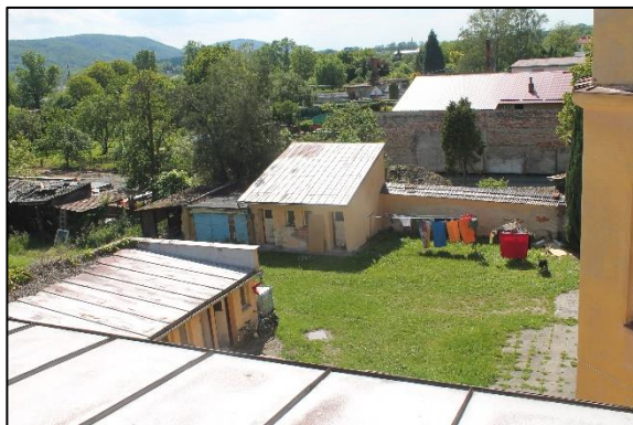
Obr. č. 3 – Vedlejší stavby na parc.č. st. 399/1
