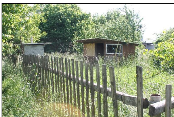
Obr. č. 27 - Chatka na parc.č. 26/1
