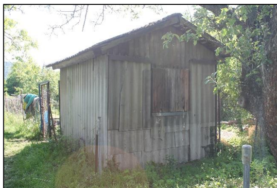
Obr. č. 26 – Chatka na parc.č. 26/1
