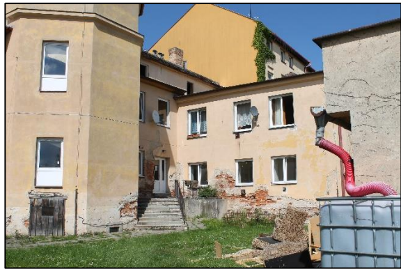
Obr. č. 2 – JV přístavba, venkovní a vnitřní schodiště
