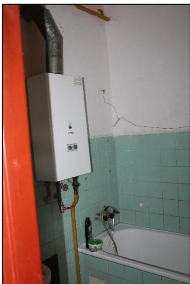
Obr. č. 15 - Koupelna bytové jednotky v 2.NP
