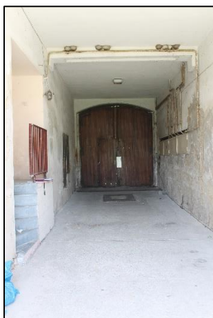
Obr. č. 7 - Průjezd budovou
