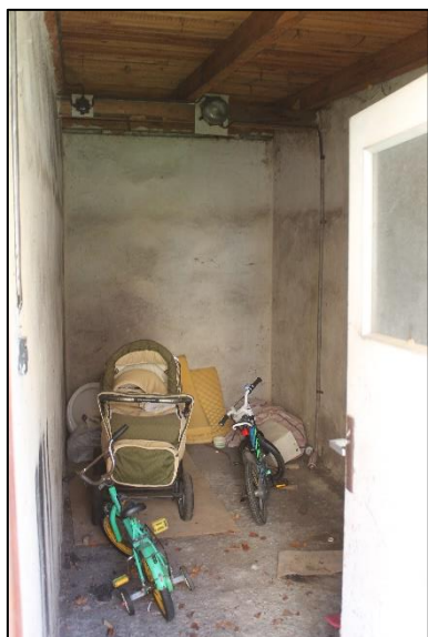
Obr. č. 23 – Skladové prostory vedlejší stavby
