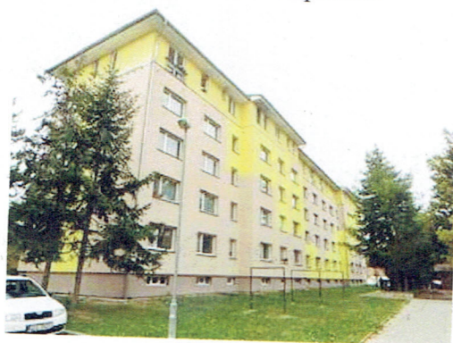
bytový dům,zadní pohled
