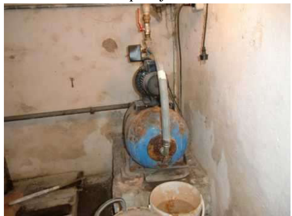
vodárna v 1.PP
