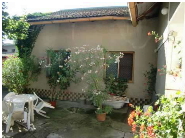
pohled ze dvora - dvorní část
