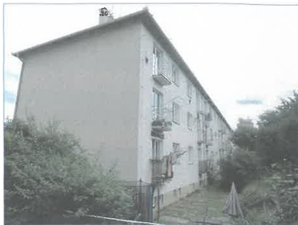
Severo-západní pohled na bytový dům
