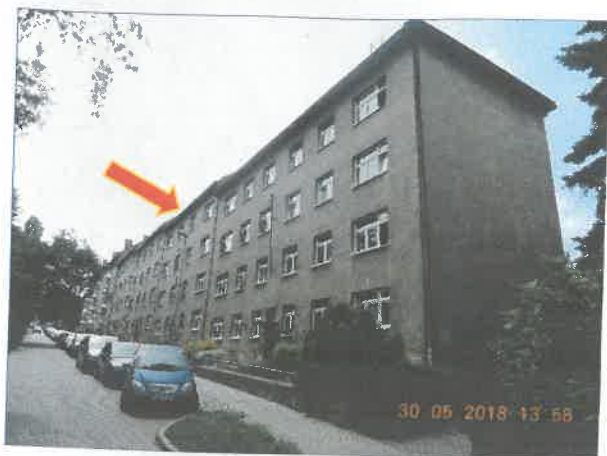
Jiho-východní pohled na bytový dům
