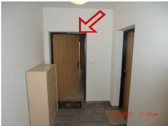
vstup do bytu z centrální chodby v 6.NP
