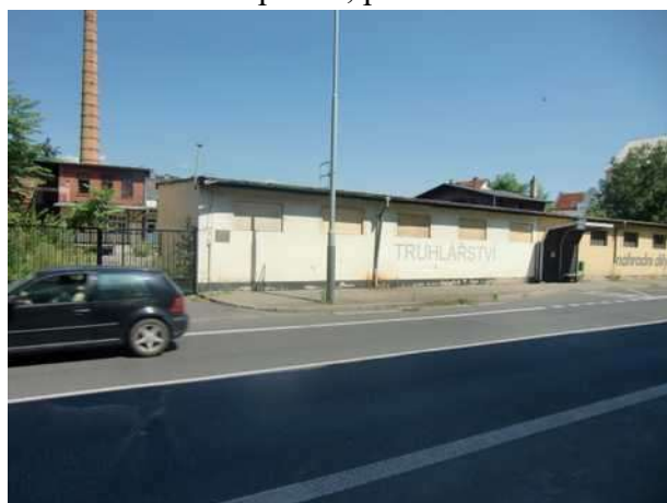
Garáže podél ulice Pekařská
