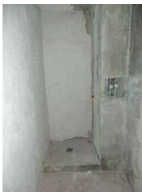
interiér 1.NP - rozestavěný byt
