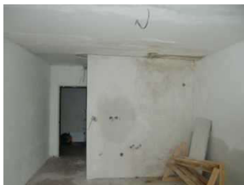
interiér 1.NP - rozestavěný byt
