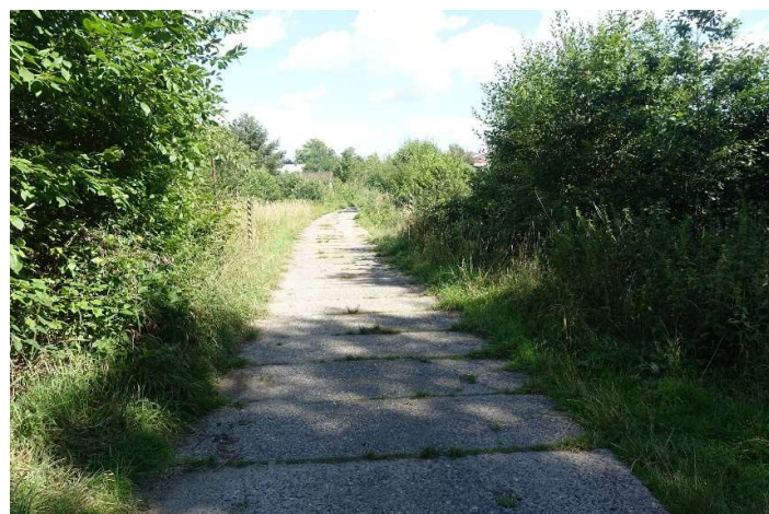
Panelová komunikace na koruně hráz
