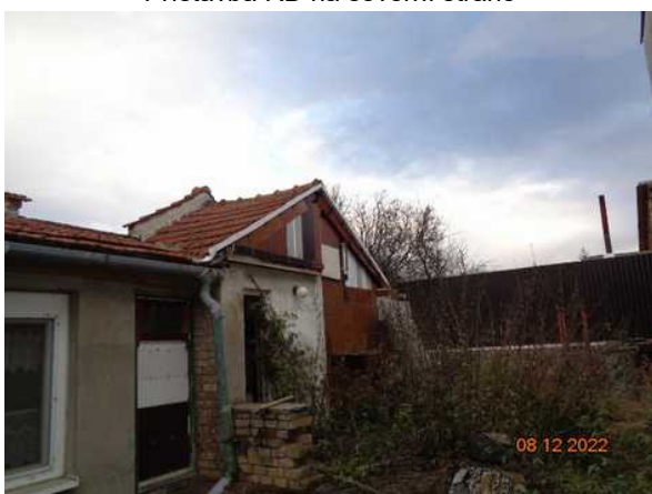
Přístavba RD a dílna se skladem
