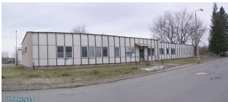
Administrativní budova na ppč. 2037/9
