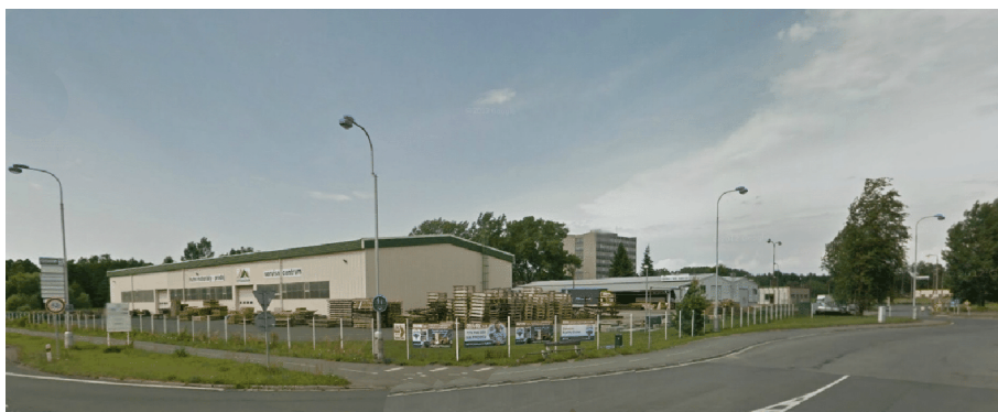
Pohled od silnice (v popředí hala na ppč. 2037/41-42)
