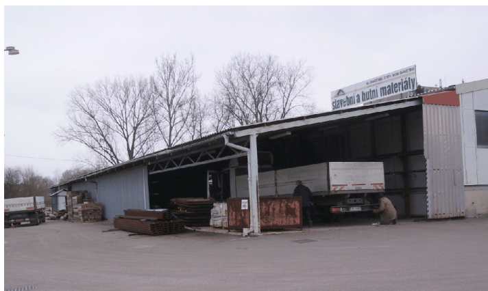
Přístřešek na ppč. 2037/13
